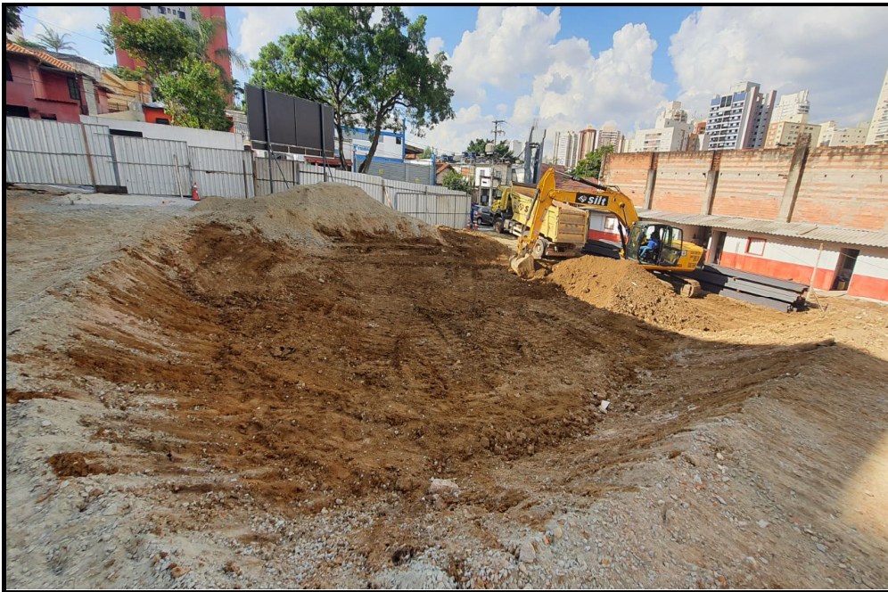
Início da escavação para execução da fundação e 2º Sub-solo.
