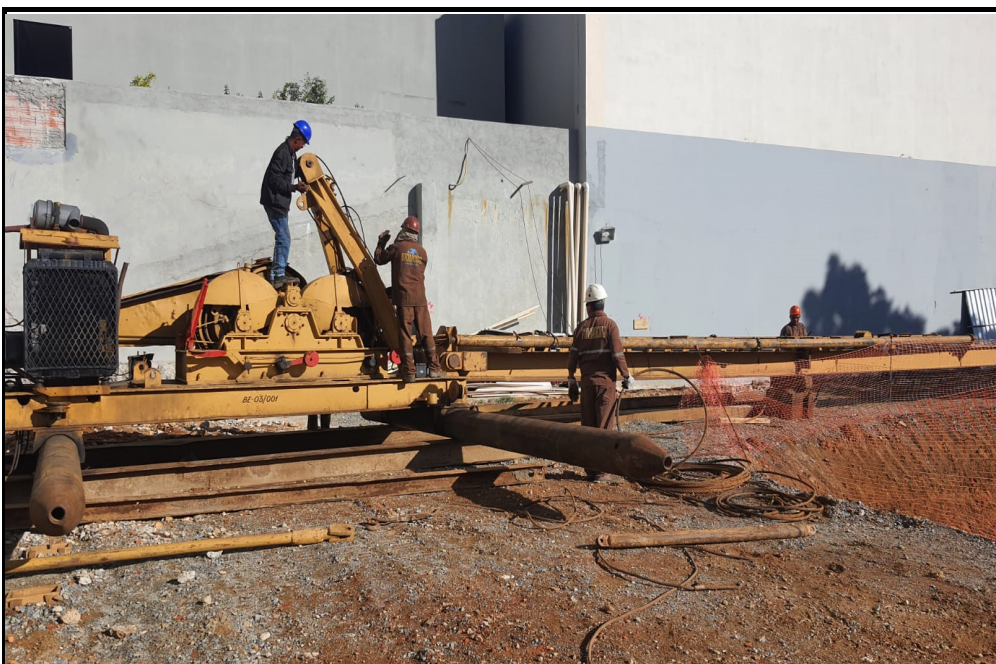
Montagem da máquina para cravação de perfil metálico.
