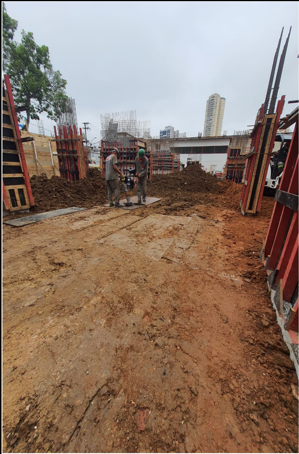
Montagem da forma para concretagem de pilares e compactação de solo.
