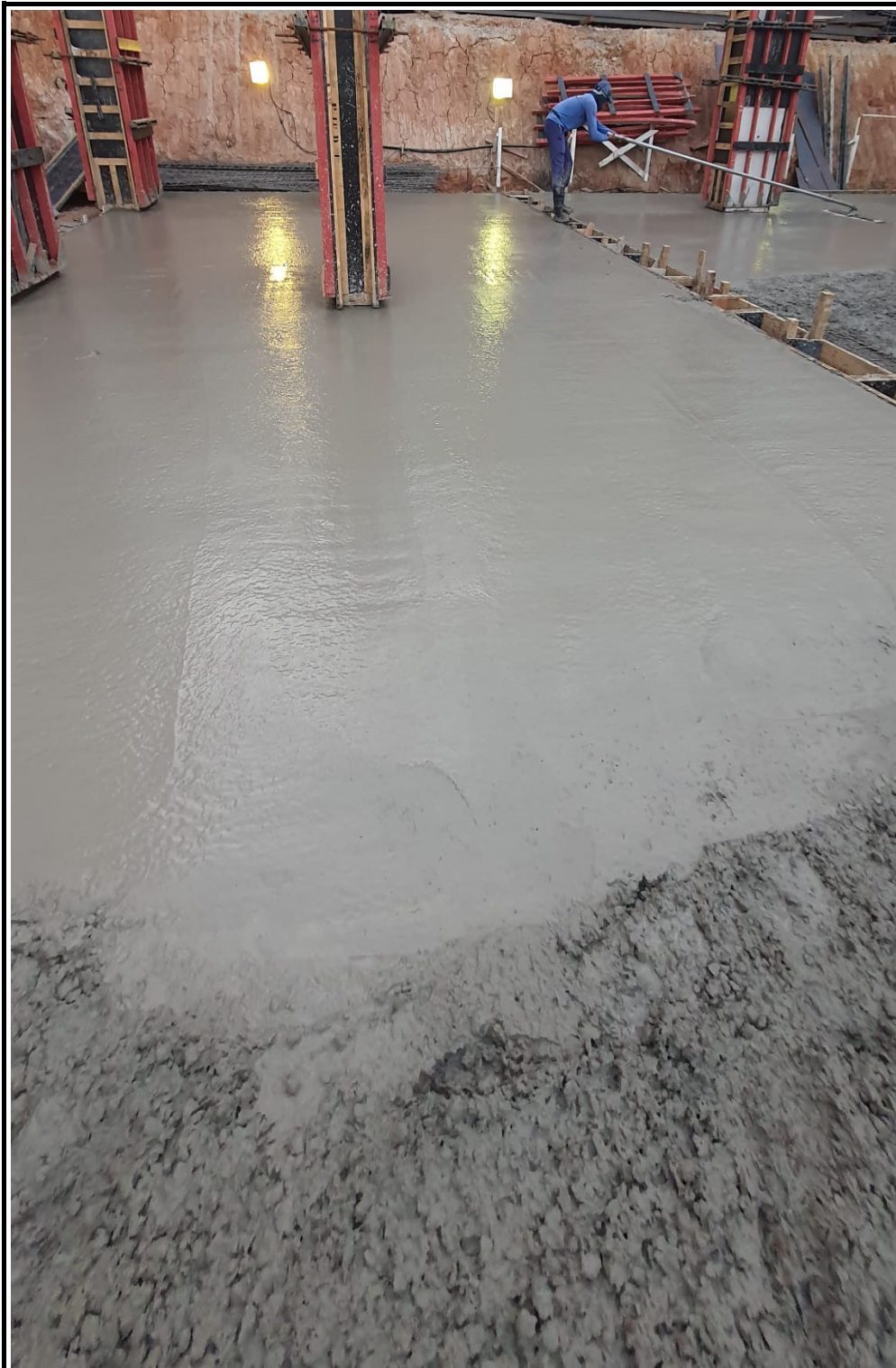
Concretagem do piso do 2º sub-solo.
