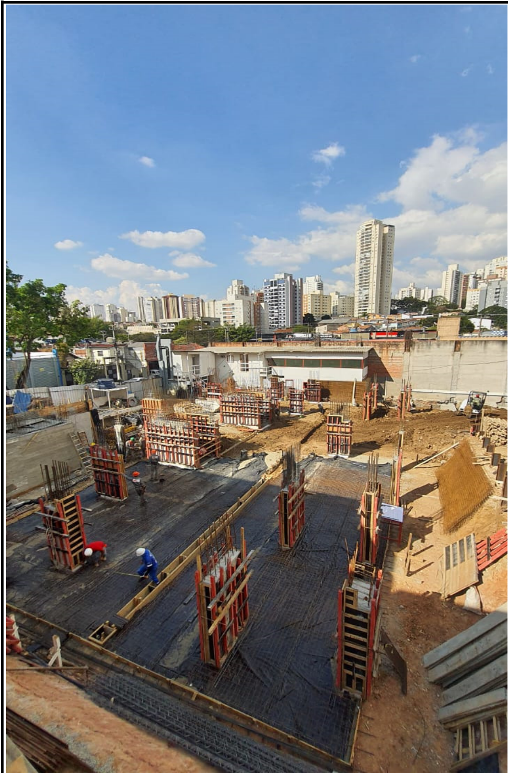
Vista geral / Preparação para concretagem do piso do 2º sub-solo.
