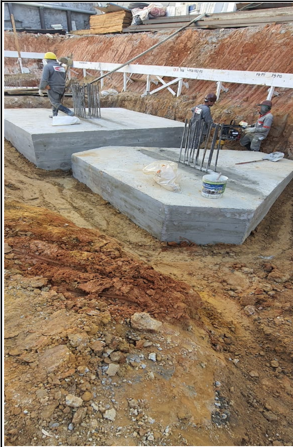
Blocos de fundação.
