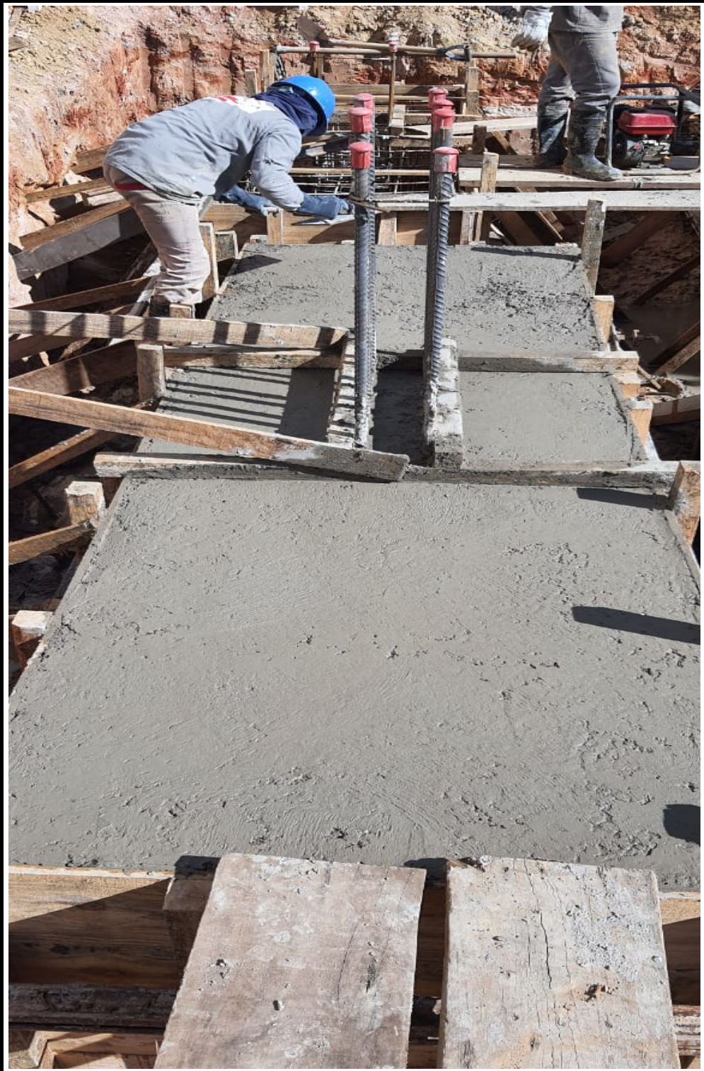
Concretagem dos blocos de fundação.
