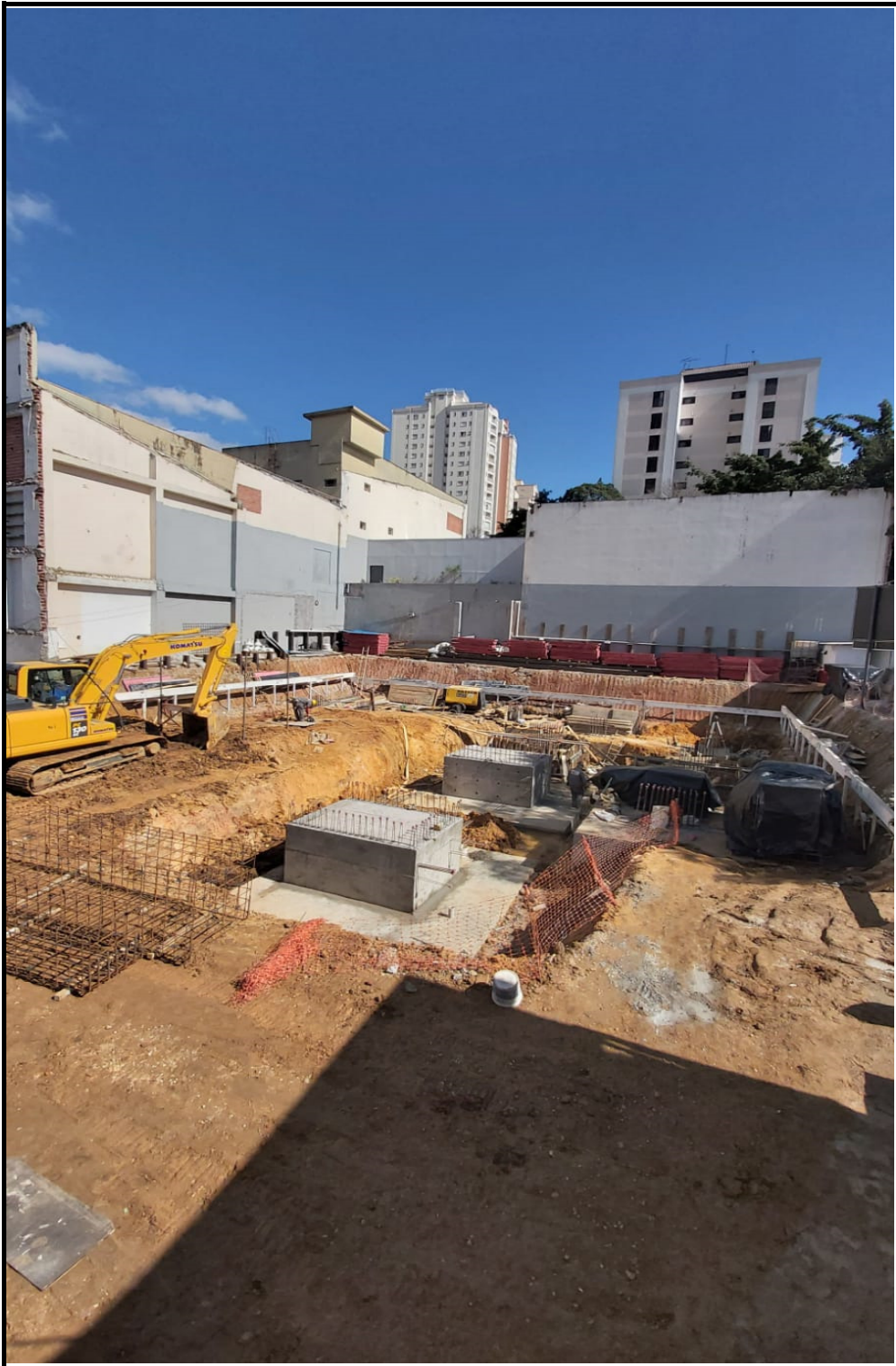
Vista geral da obra.
