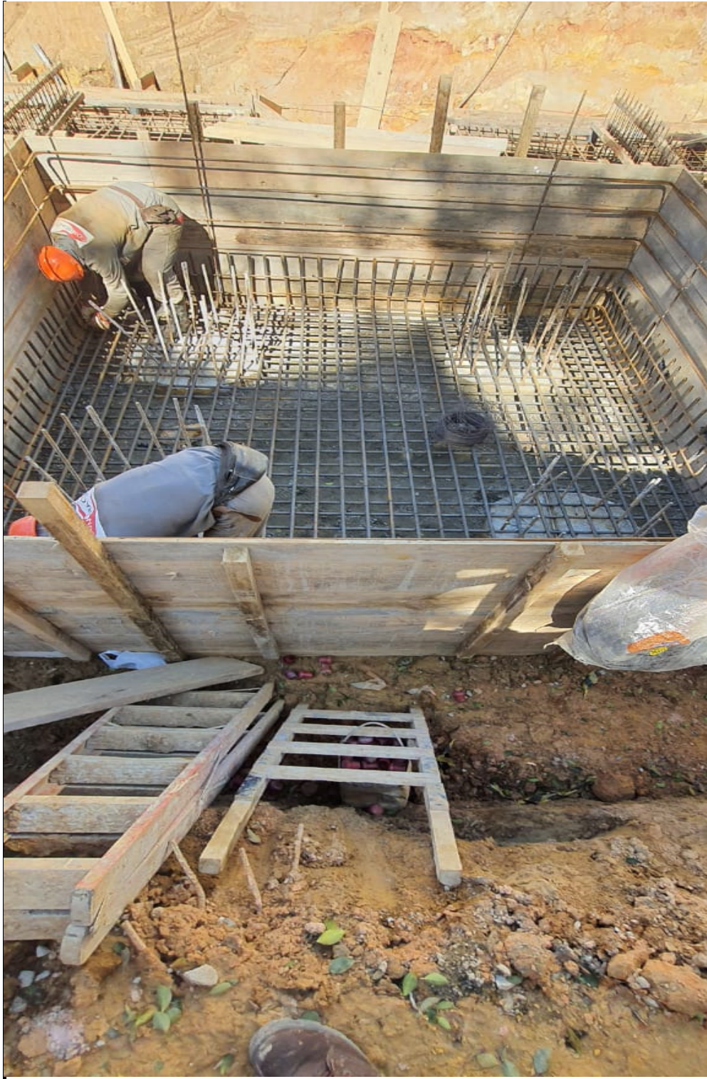
Preparação dos blocos de fundação.
