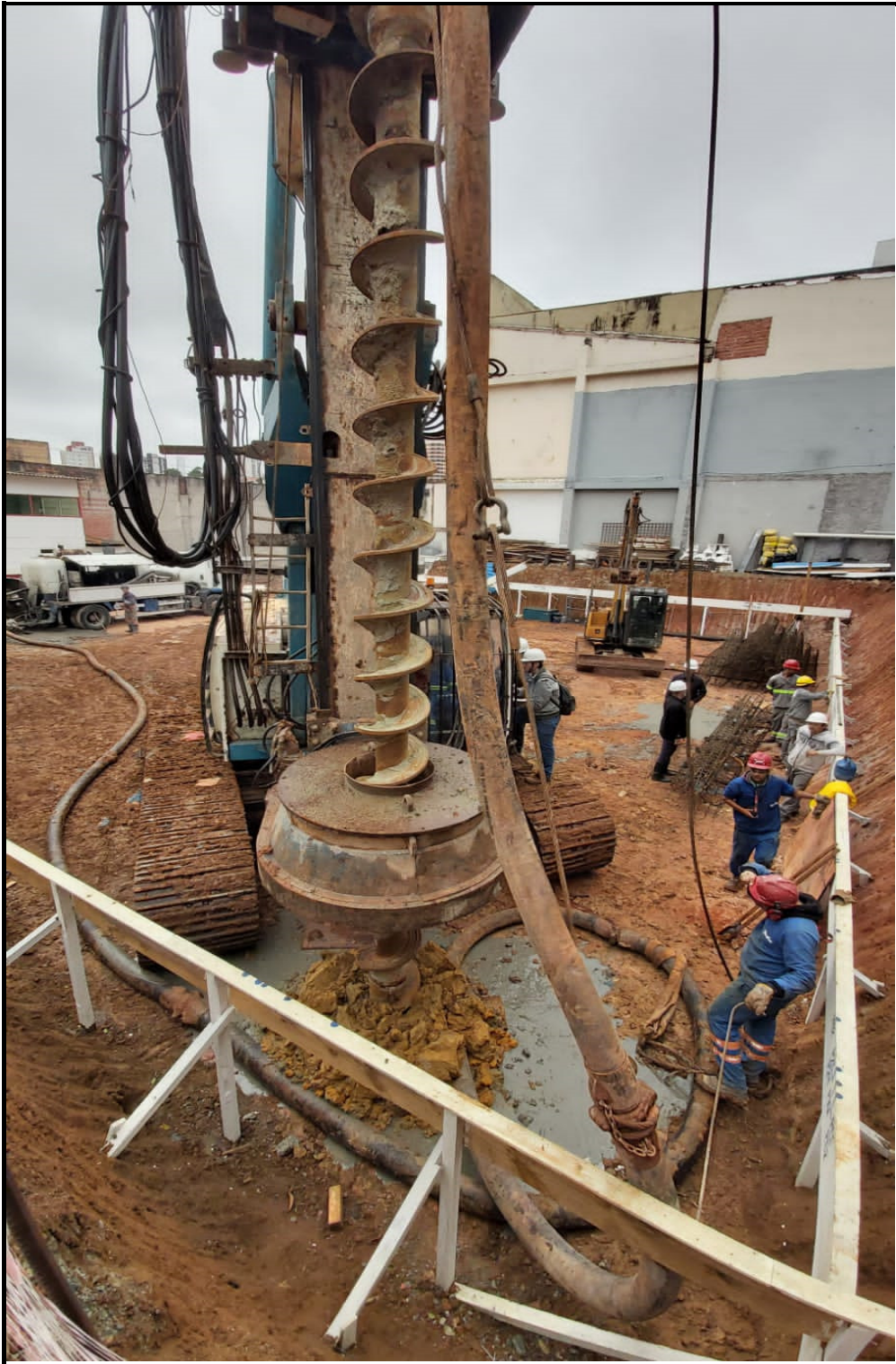
Execução de estacas para fundação profunda.
