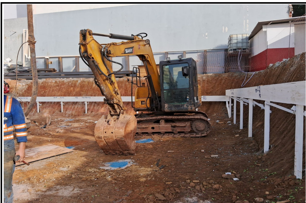
Gabarito da fundação / marcação das estacas.
