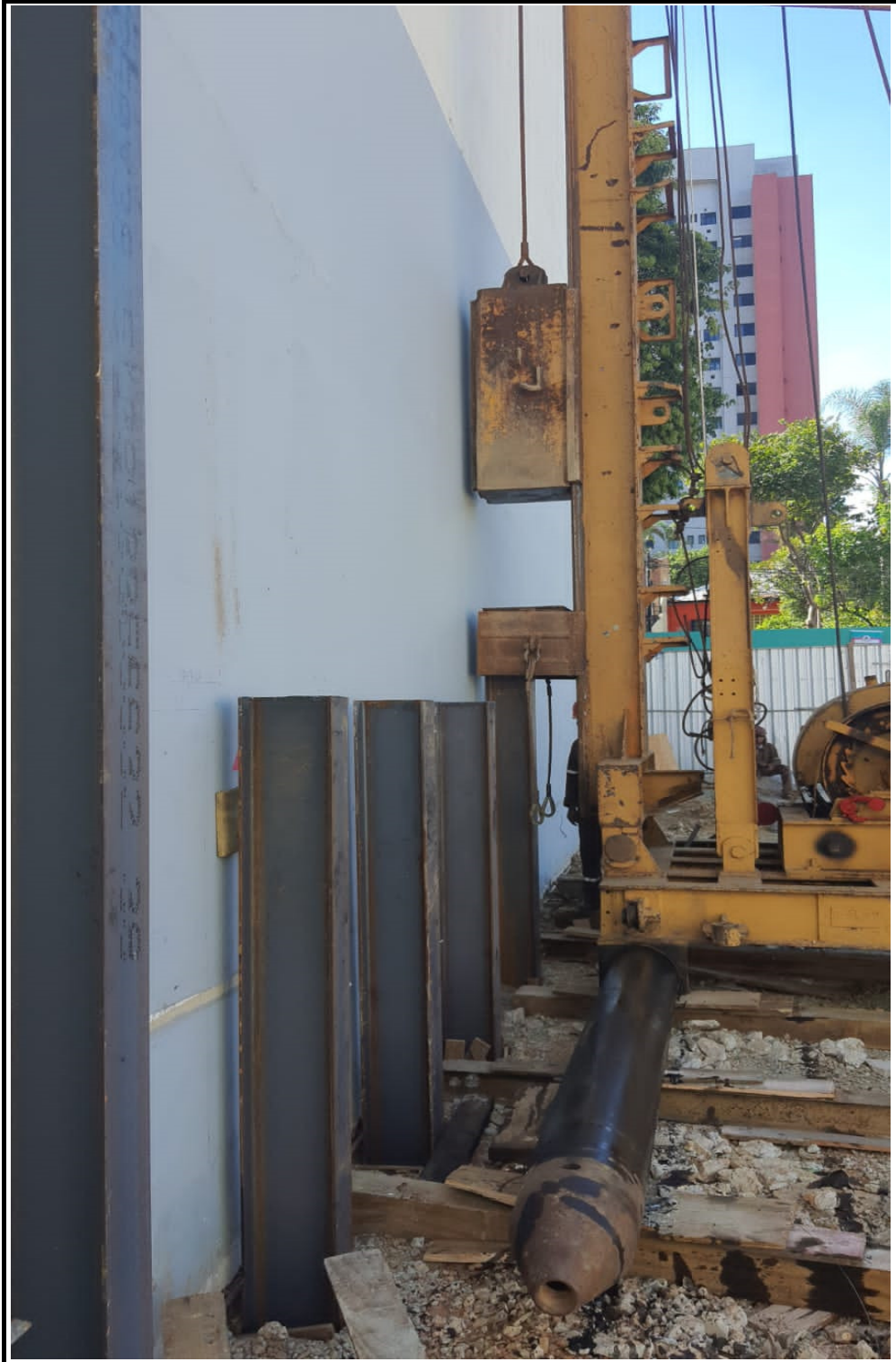
Cravação de perfil metálico para contenção de vizinhos.
