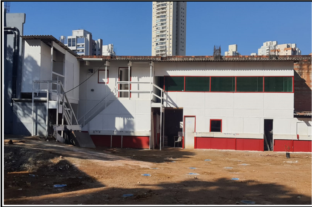
Canteiro de obras.
