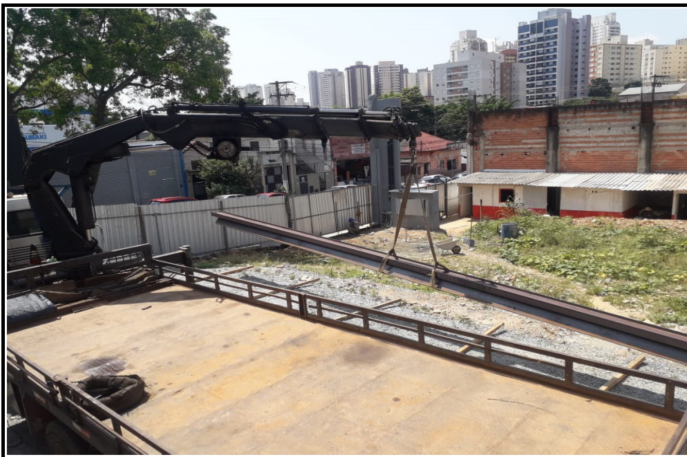
Descarga de perfil metálico para contenção de vizinhos.
