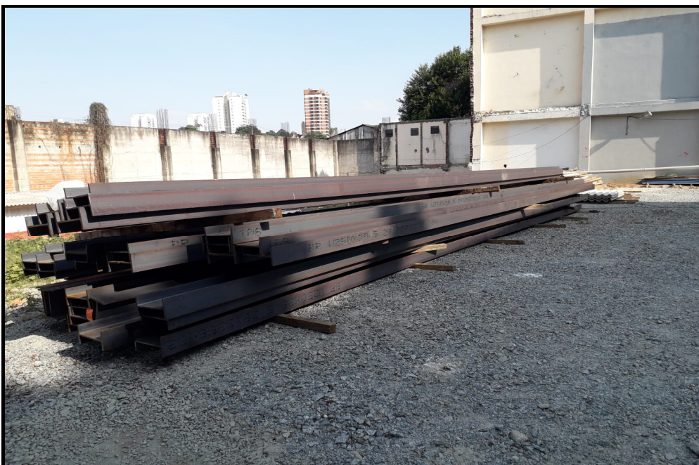
Perfil metálico para contenção de vizinhos.
