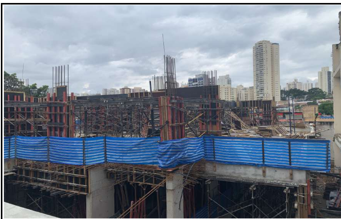
Vista da obra - Rua Santo Irineu.
