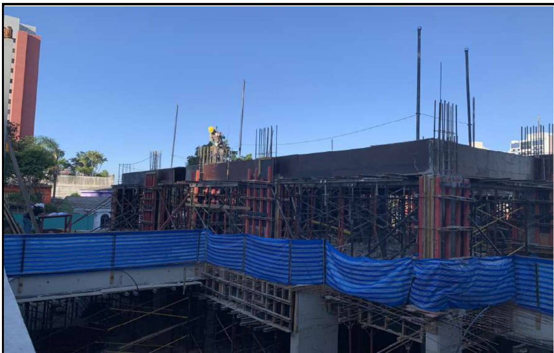
Montagem da forma da laje do 1º Pavimento.
