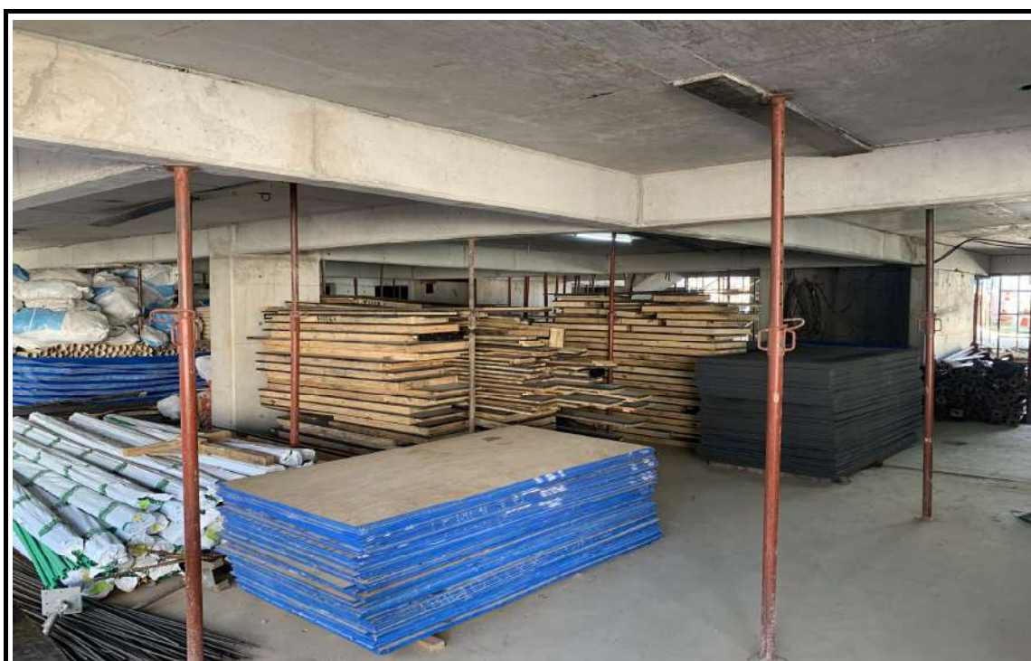
Material para montagem da forma dos pavimentos tipos.
