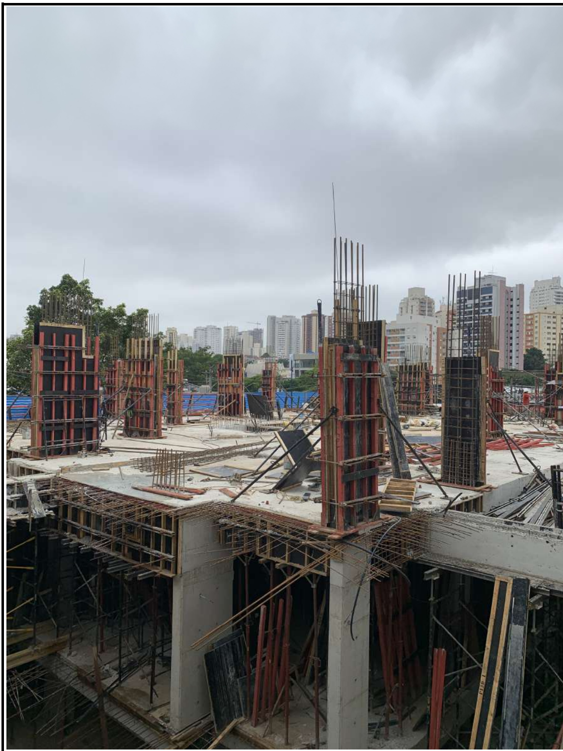
Forma e armação para concretagem dos pilares do 1º pavimento.
