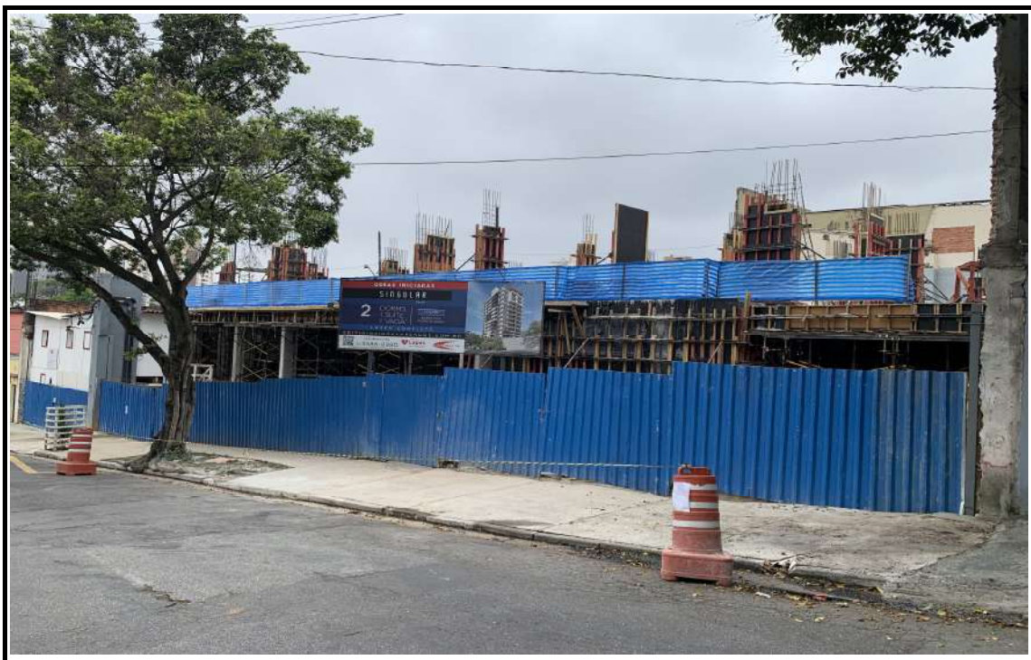
Vista da obra - Rua Dom Bernardo Nogueira.
