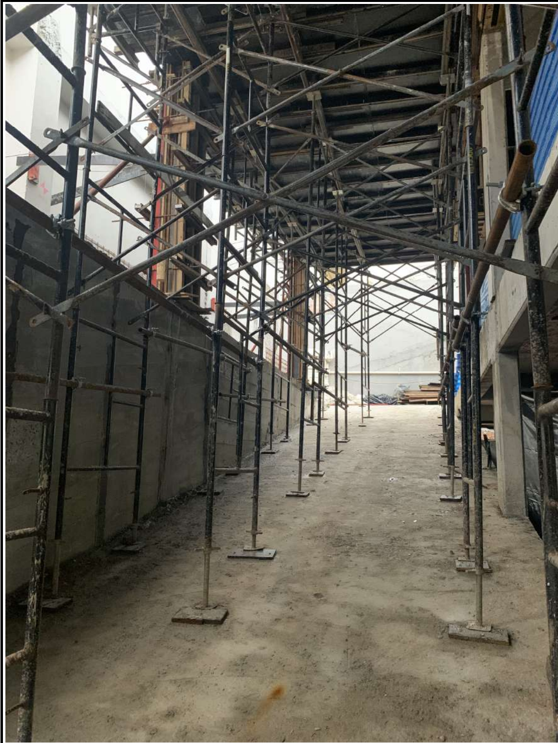
Escoramento em pé-direito duplo da laje do térreo.
