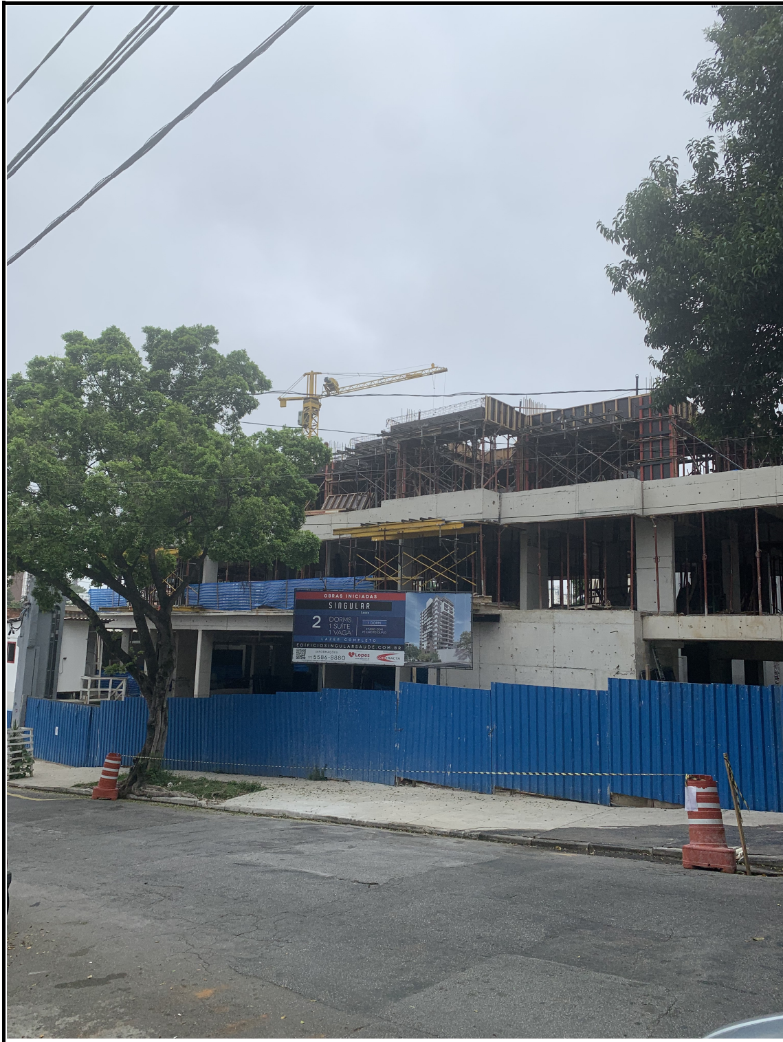
Vista da obra - Rua Dom Bernardo Nogueira.
