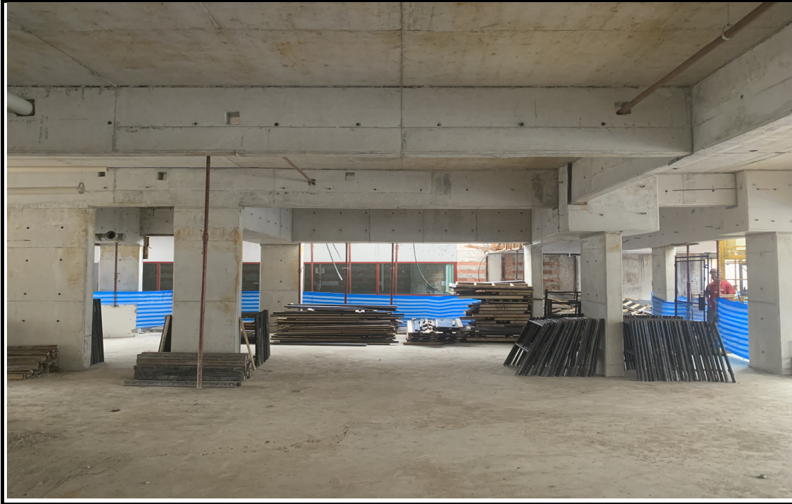
Estrutura de concreto do 1º sub-solo
