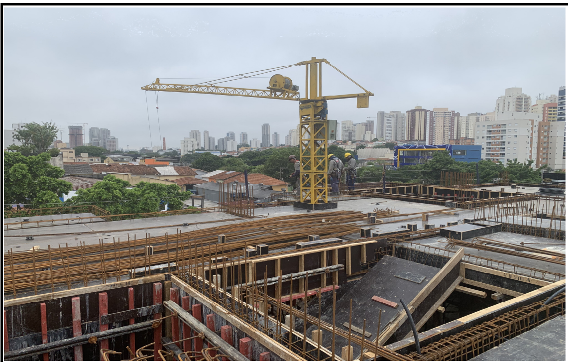
Montagem de armação para concretagem da laje do 2º Pavimento.
