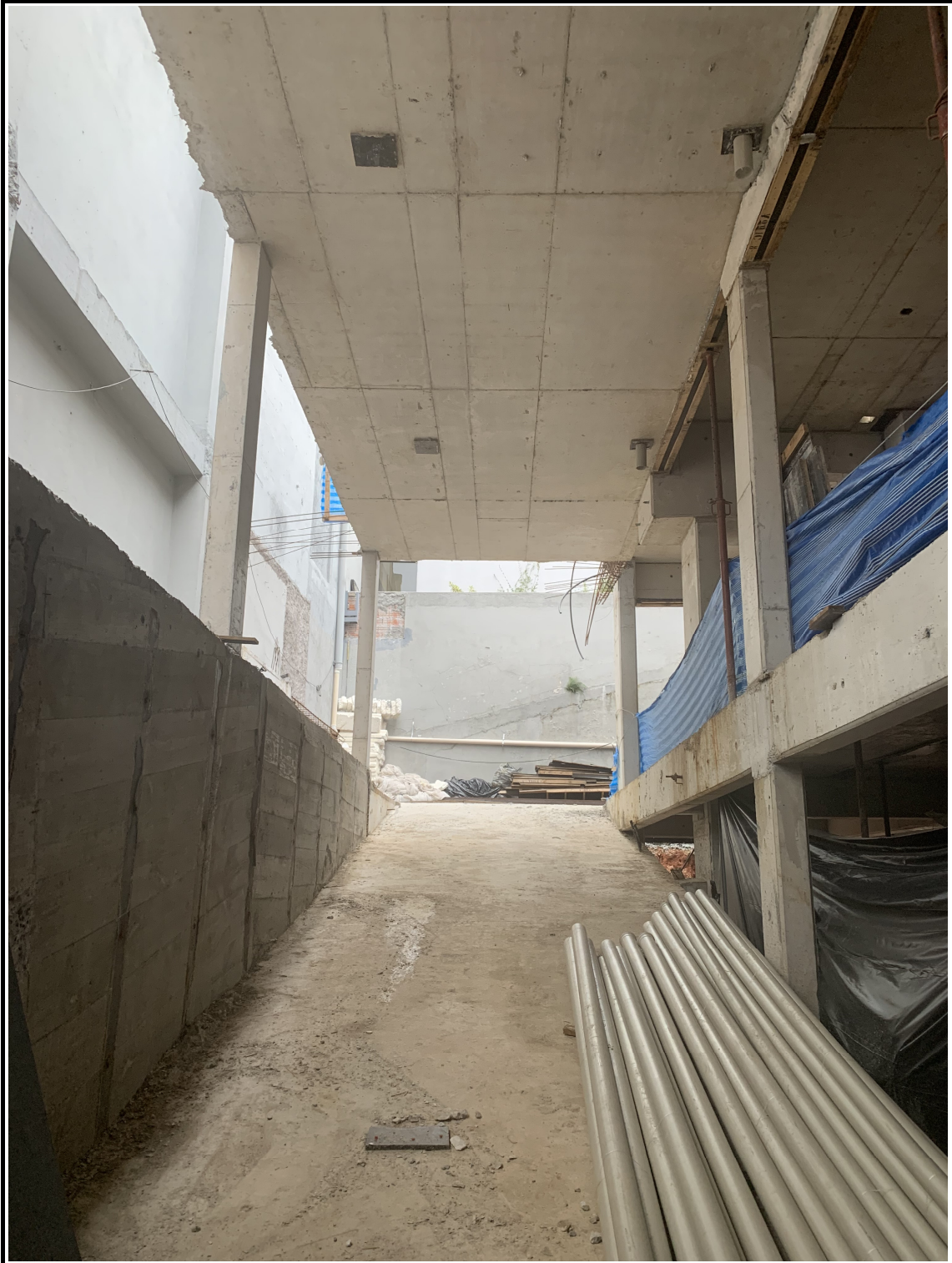
Rampa de acesso ao 1º sub-solo.
