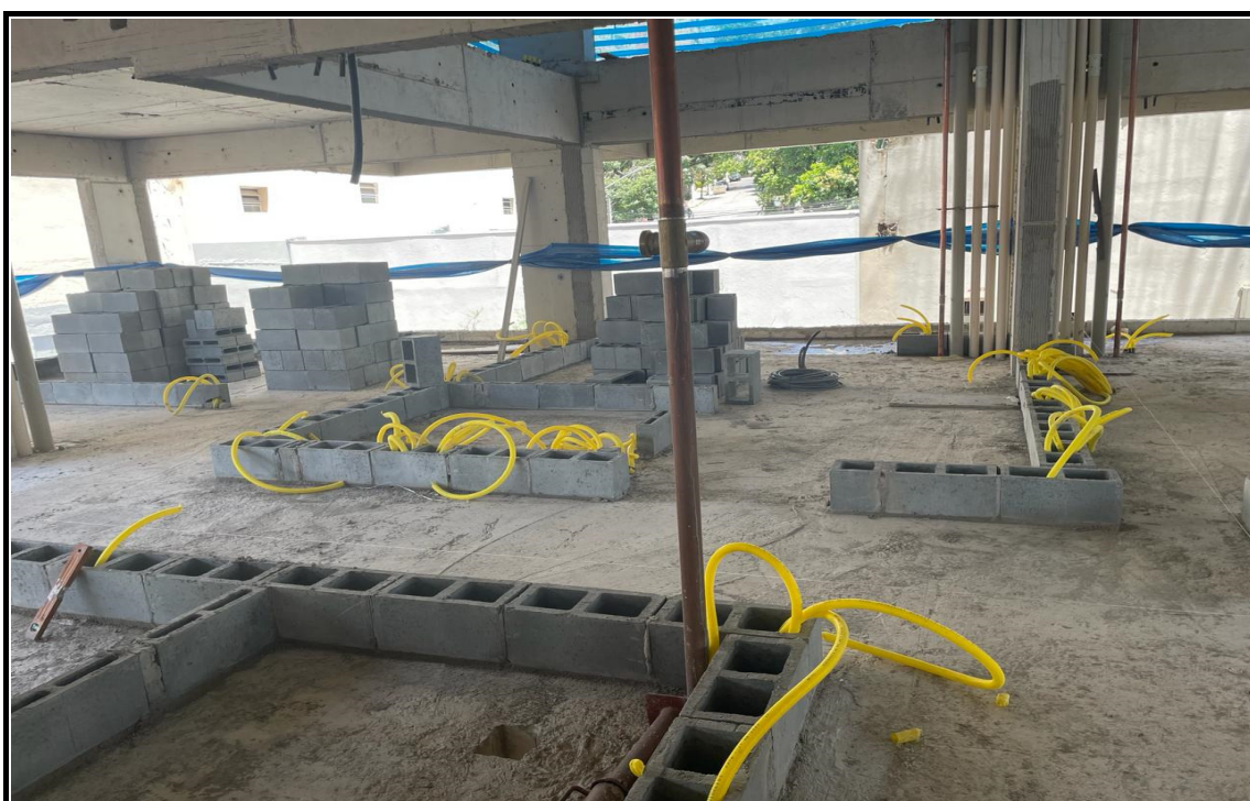
Execução de alvenaria - marcação 1ª fiada e colocação de conduites embutidos.
