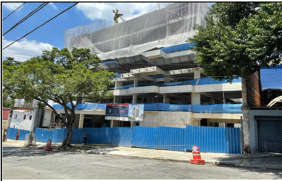
Vista da obra - Rua Dom Bernardo Nogueira.
