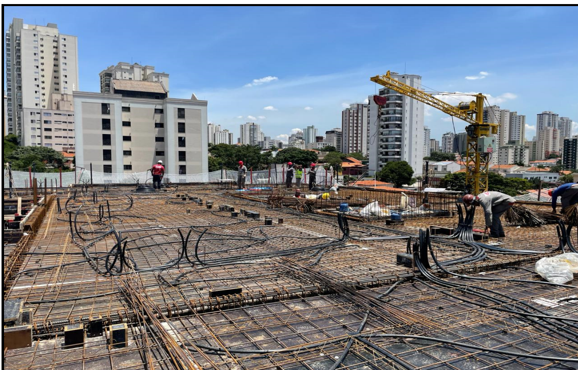
Preparação para concretagem - laje do 6º pavimento.
