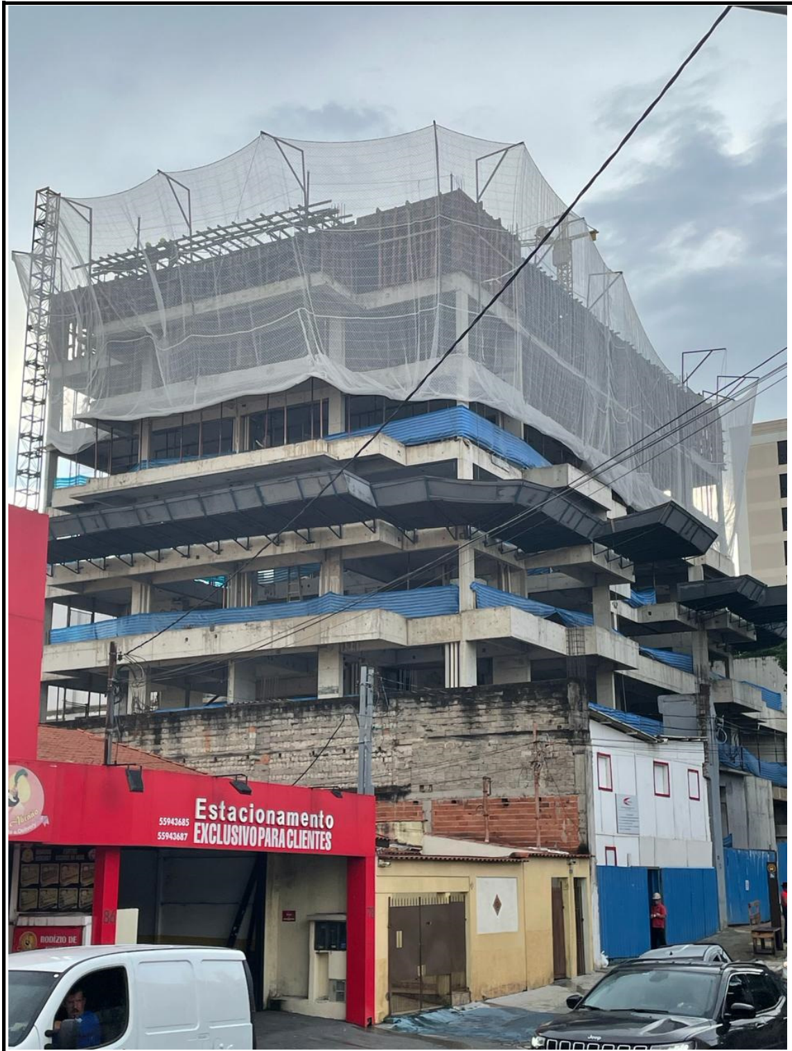
Vista da obra - Av. Dr. Ricardo Jafet.
