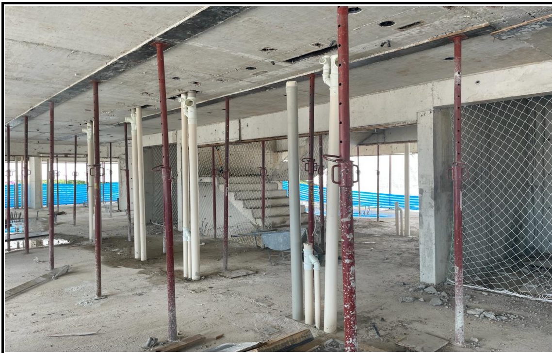
Montagem de tubulação hidráulica e escoramento da laje até cura final do concreto.
