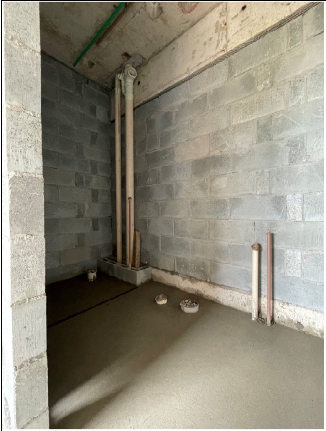
Execução de alvenaria, instalação hidráulica e contra-piso.
