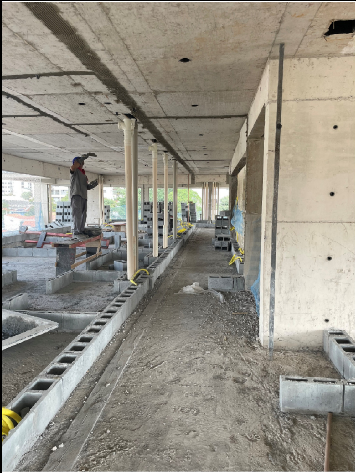
Execução de marcação de alvenaria - 1ª fiada.
