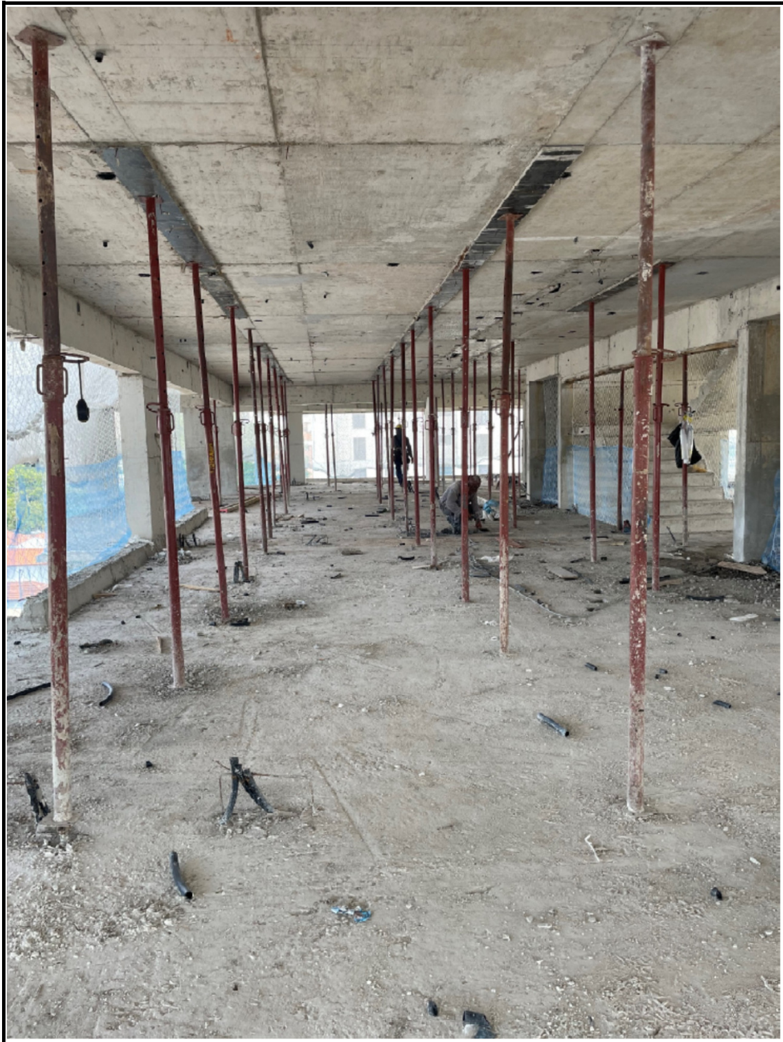
Laje com reescoramento final antes da cura do concreto.
