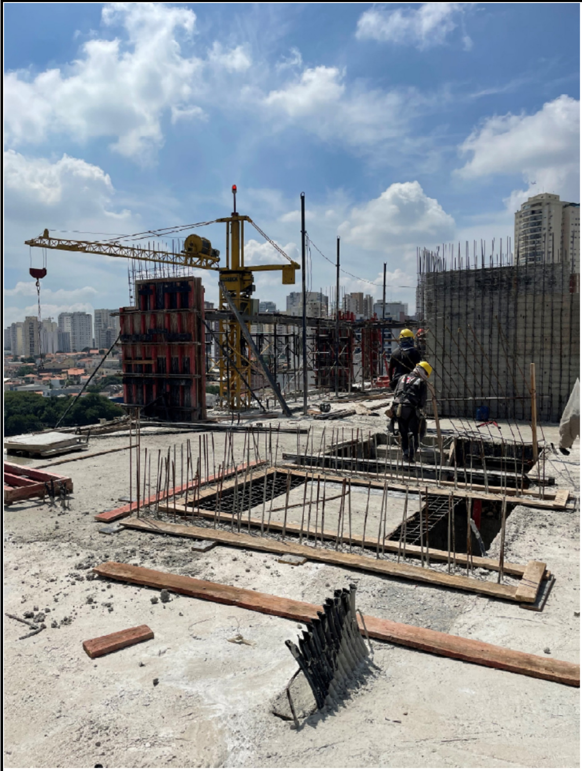
Montagem da forma para concretagem do 11º pavimento.
