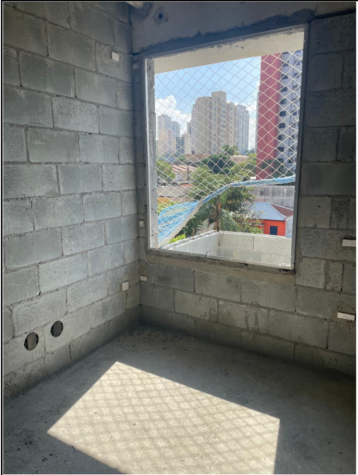
Chumbamento de contra-marco para instalação de esquadria de alumínio.
