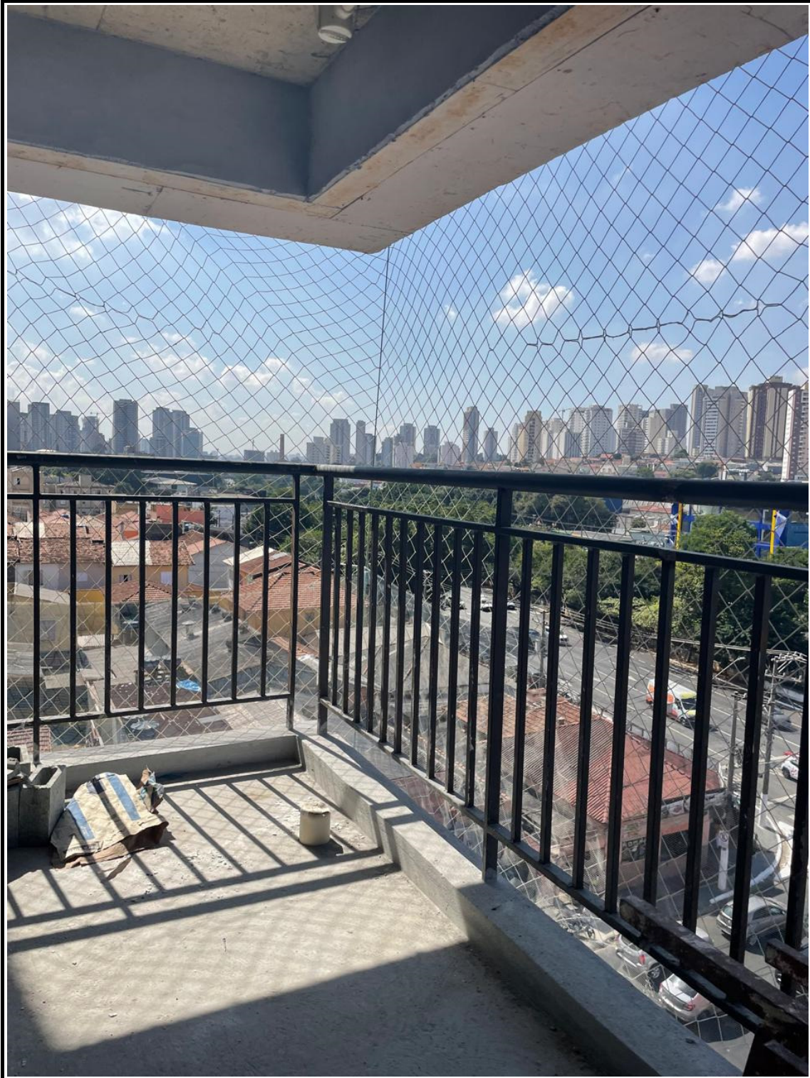
Instalação de guarda-corpo no terraço do apartamento modelo.
