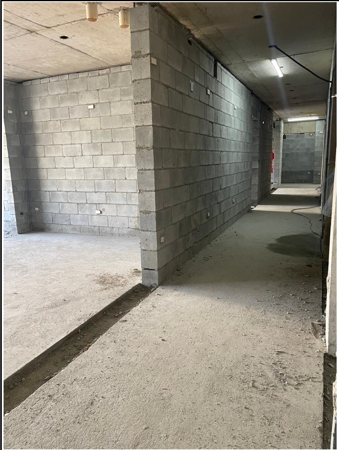
Execução de alvenaria e contra-piso.
