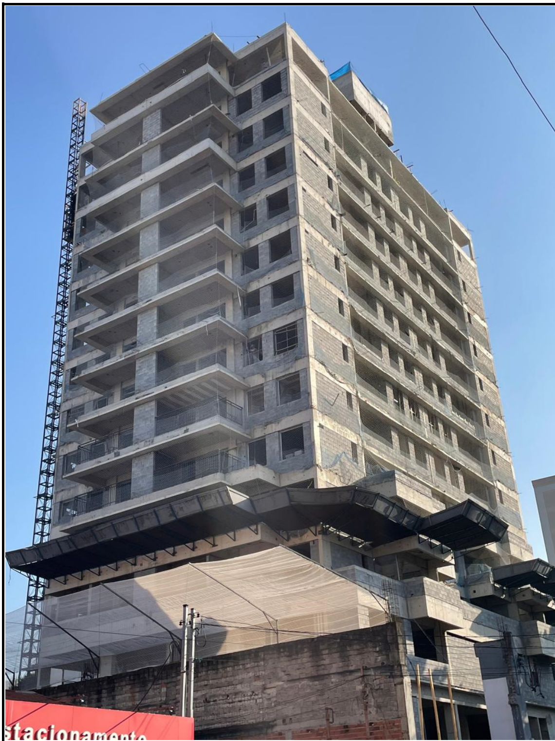
Vista obra Av. Ricardo Jafet
