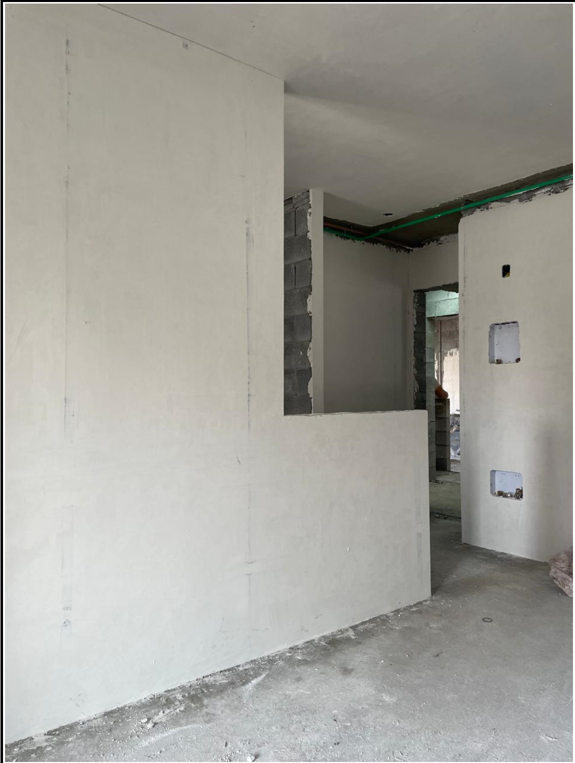
Aplicação de gesso liso em paredes e tetos.
