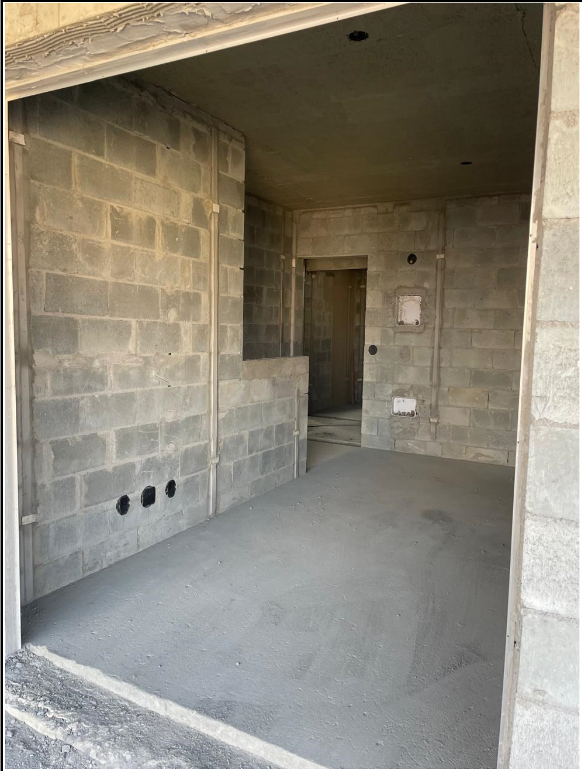
Execução de alvenaria, contra-piso e instalação elétrica.
