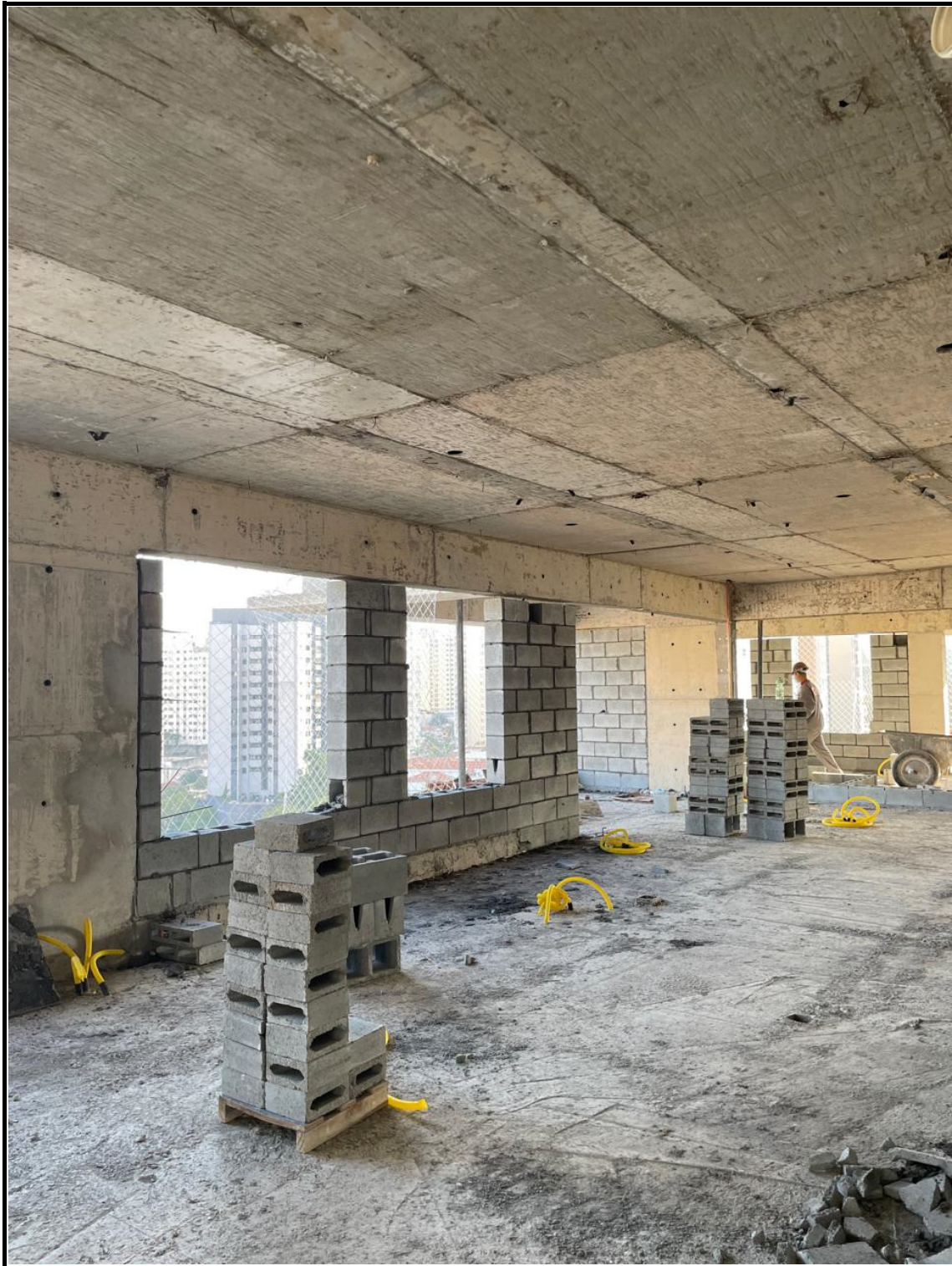
Marcação de alvenaria interna nos últimos pavimentos.
