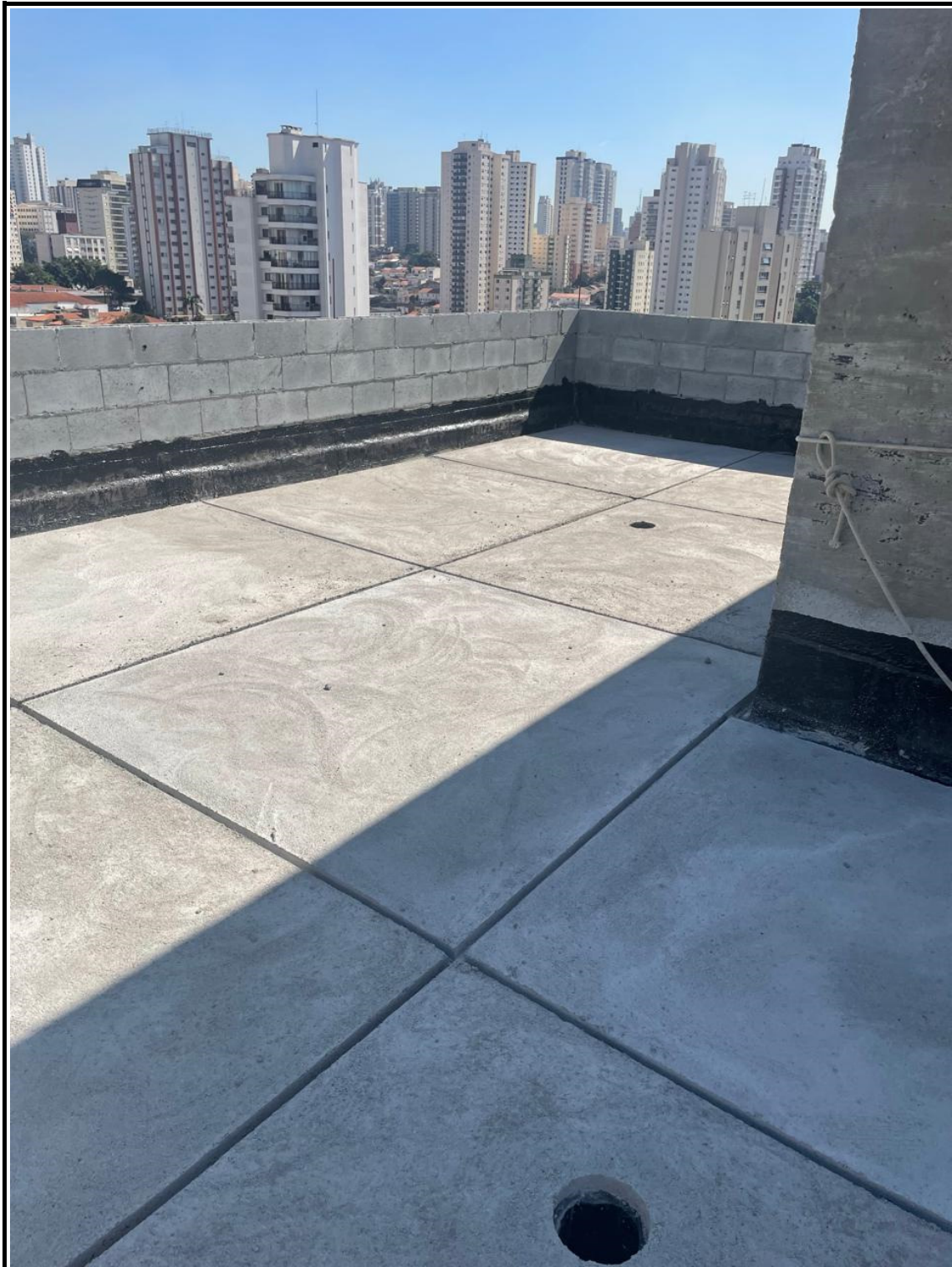
Impermeabilização e proteção mecânica - laje cobertura.
