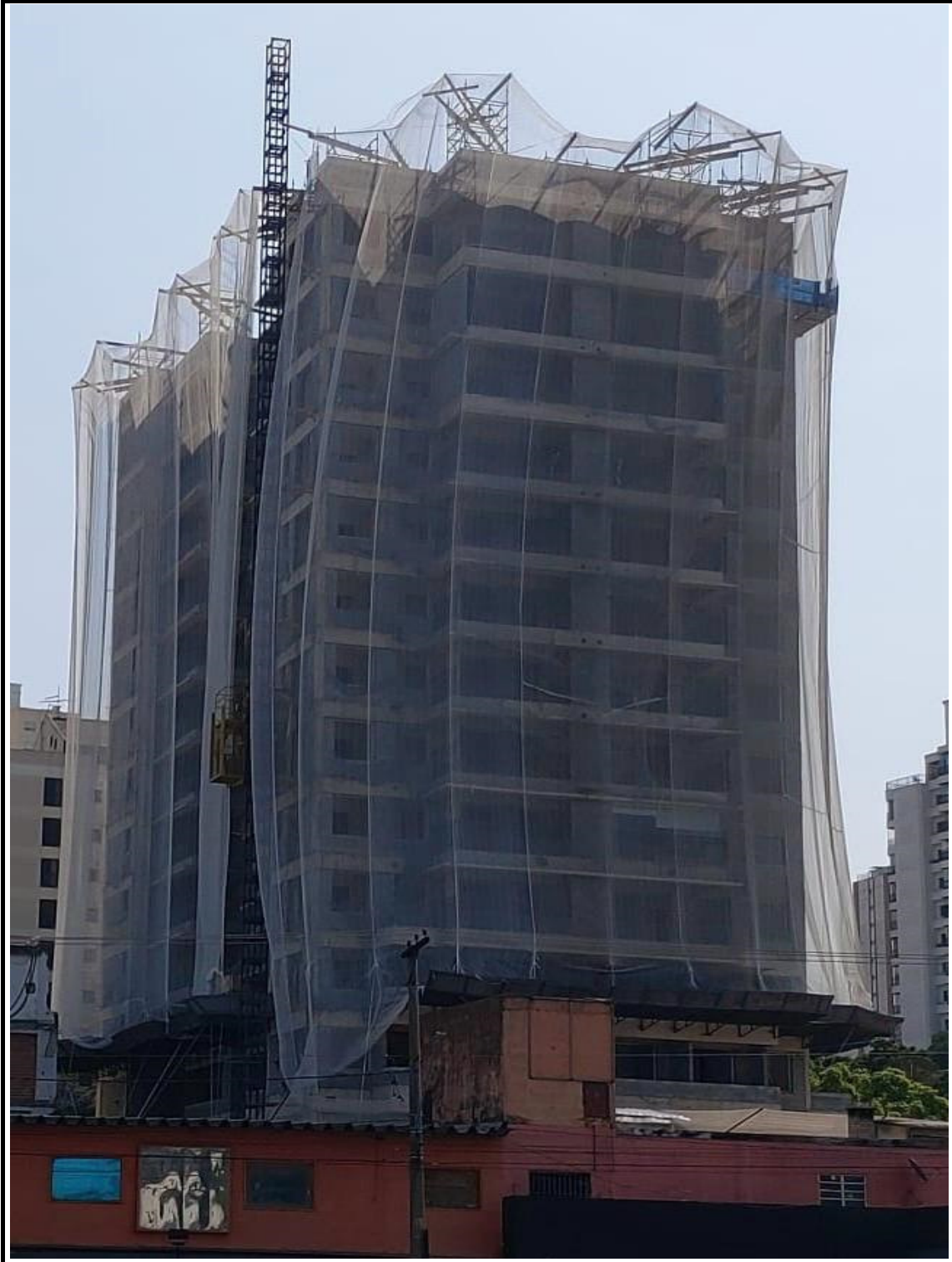
Instalação da tela fachadeira - execução de revestimento externo.
