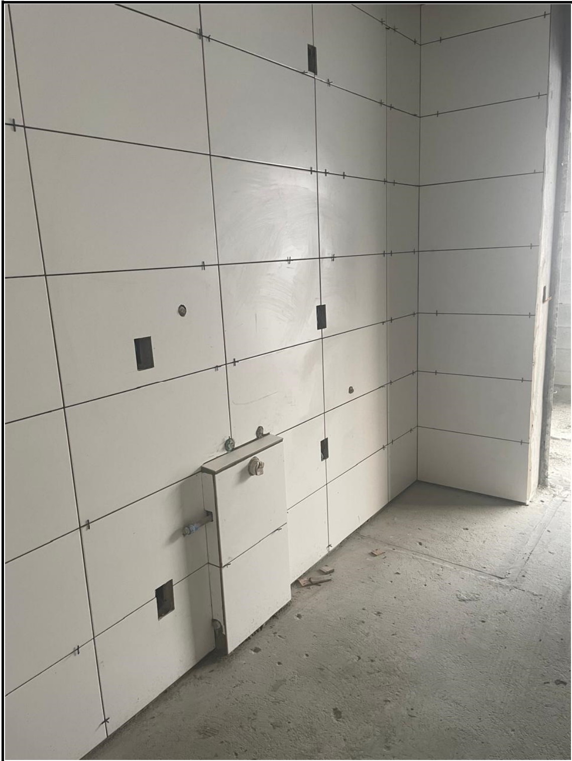
Execução de revestimento cerâmico.
