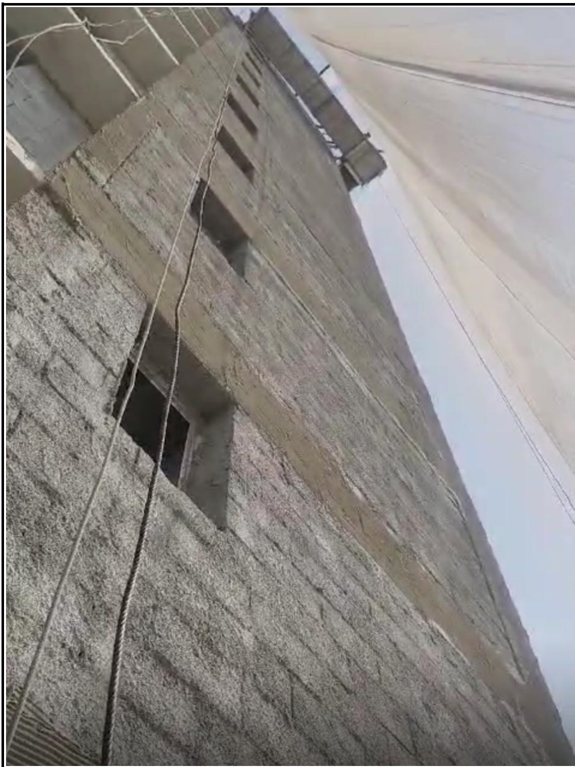
Execução de revestimento externo - massa na fachada.
