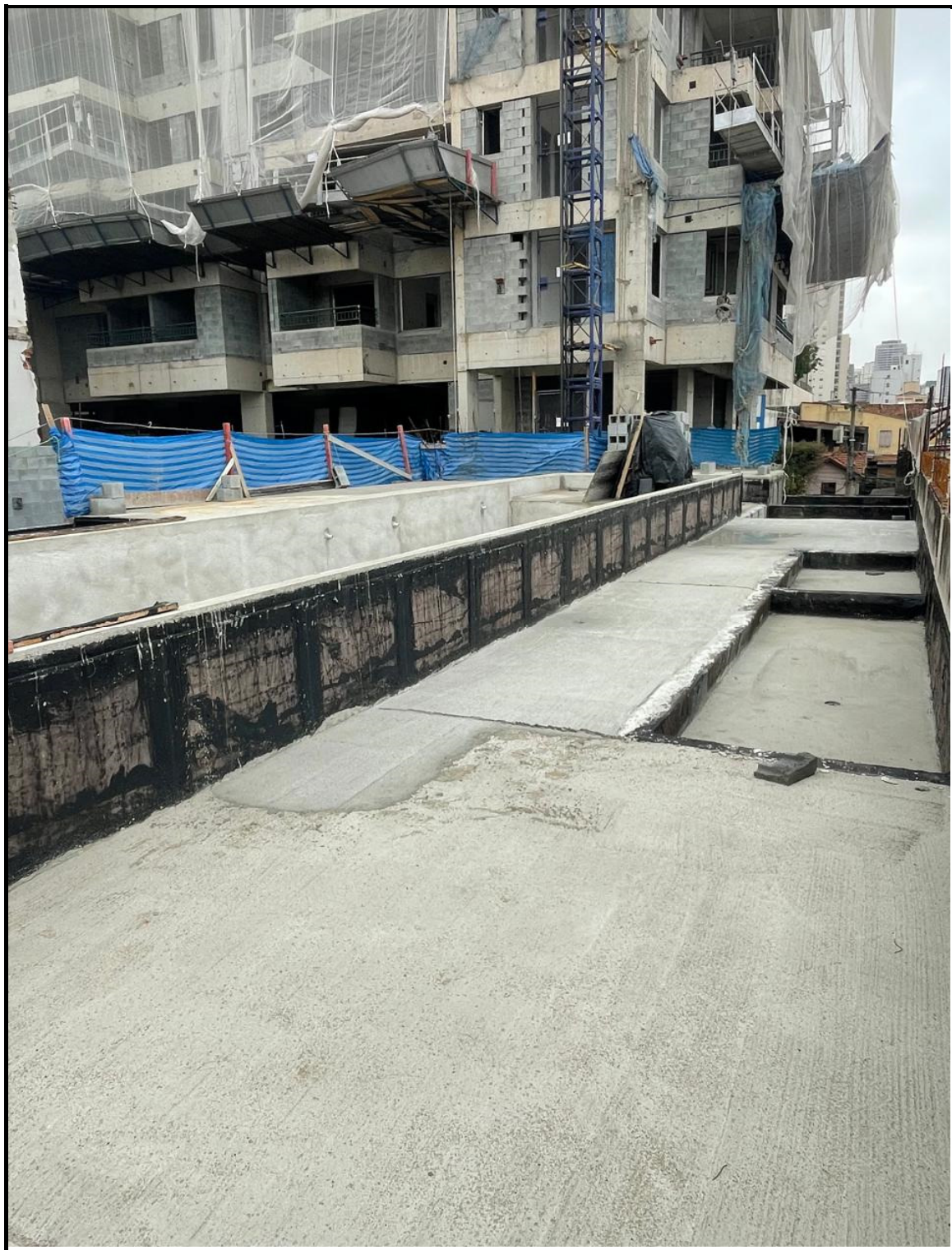
Impermeabilização de área externa.
