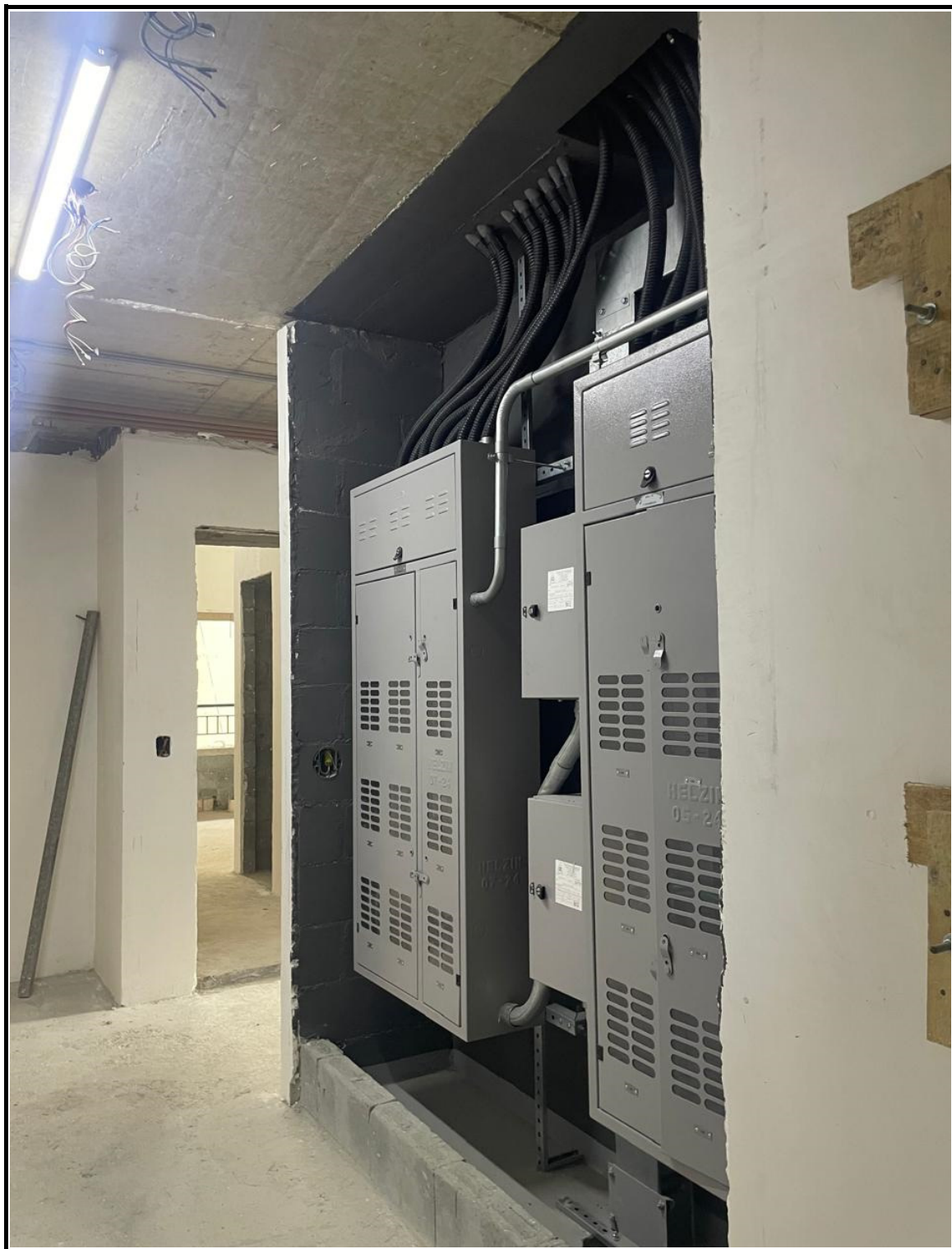
Instalação de quadros elétricos.
