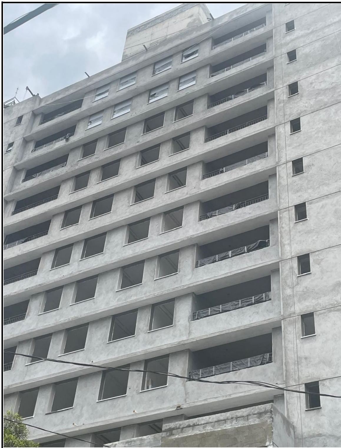
Execução de revestimento externo na fachada e instalação de esquadrias de alumínio.
