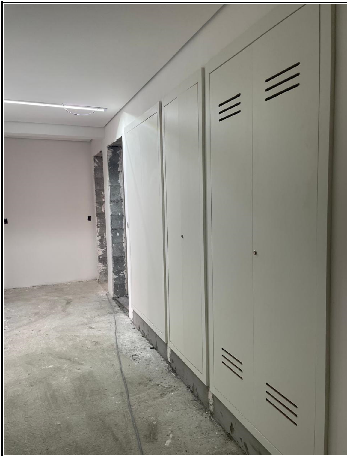
Instalação de portas de madeira para fechamento dos shafts dos andares.
