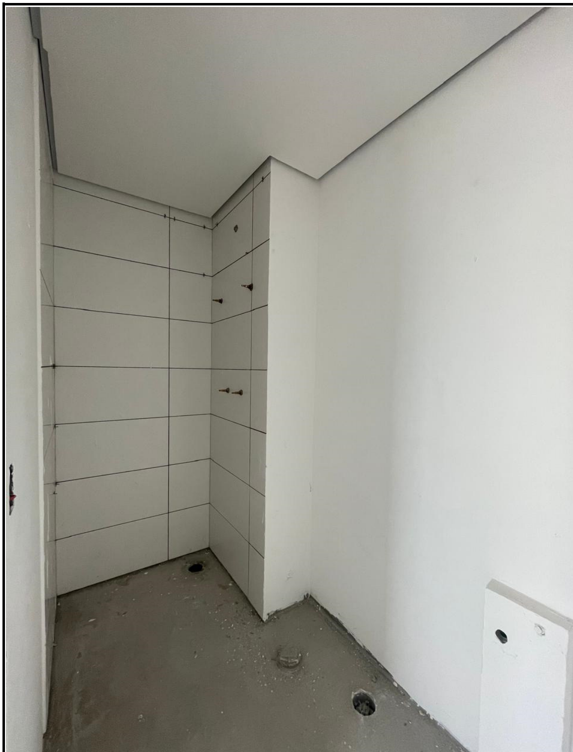
Revestimento cerâmico em banheiros.
