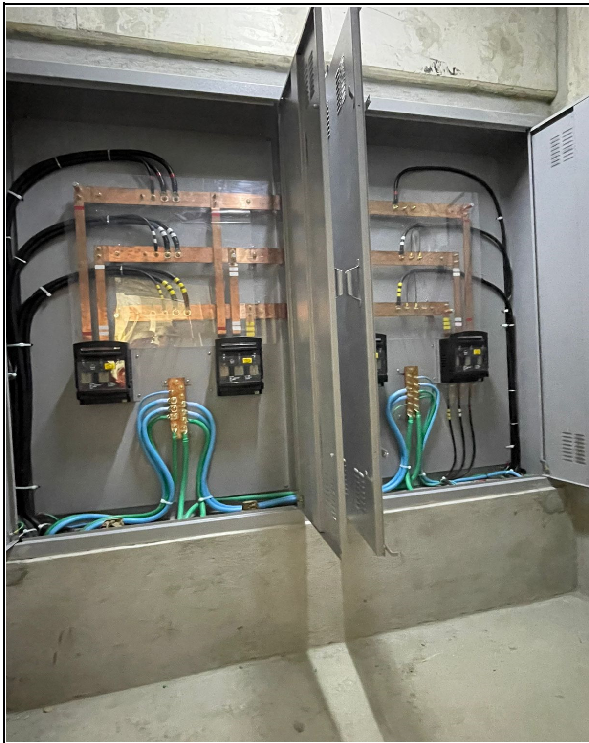
Instalação de quadros elétricos.
