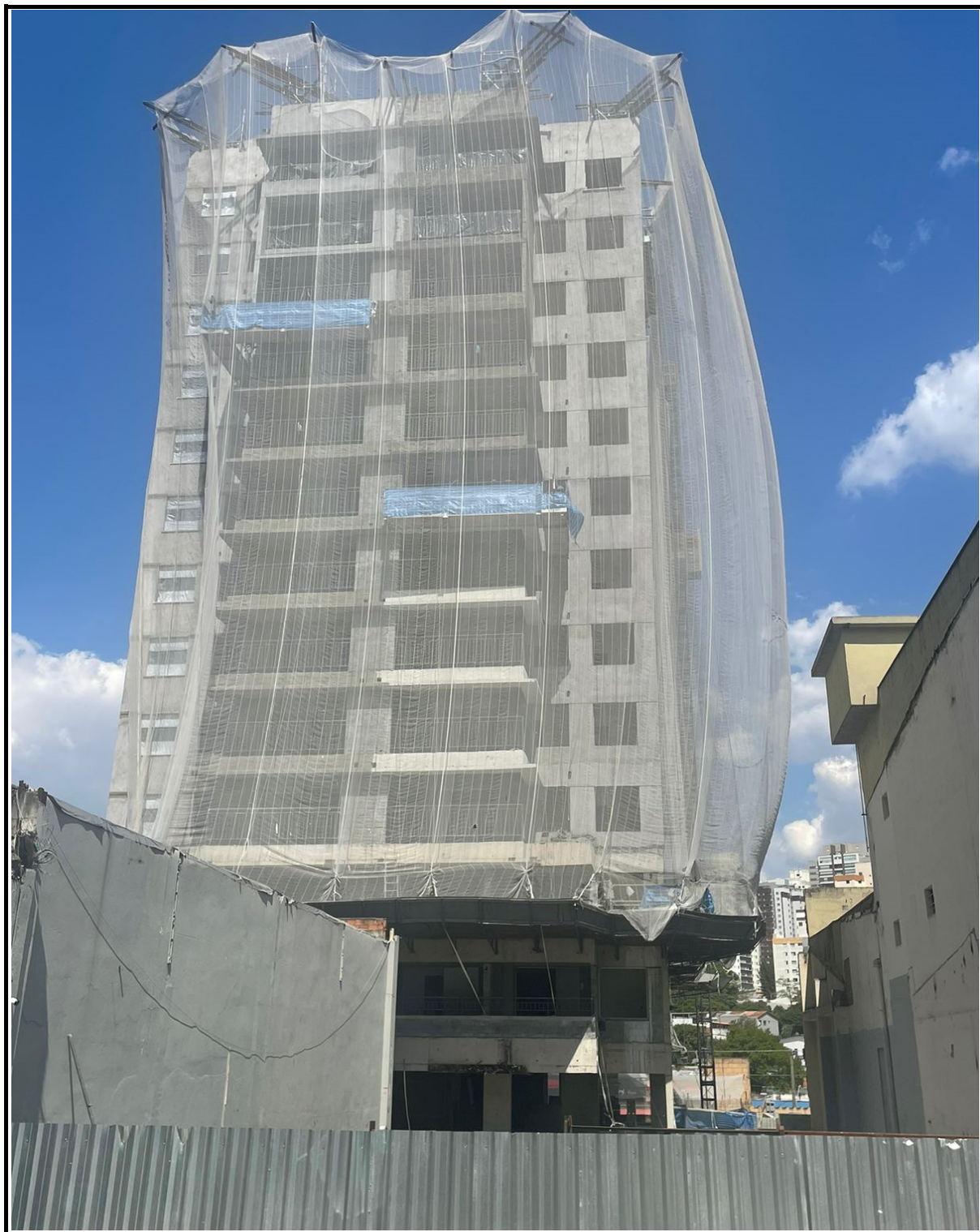
Fachada Rua Santo Irineu - execução de revestimento externo.
