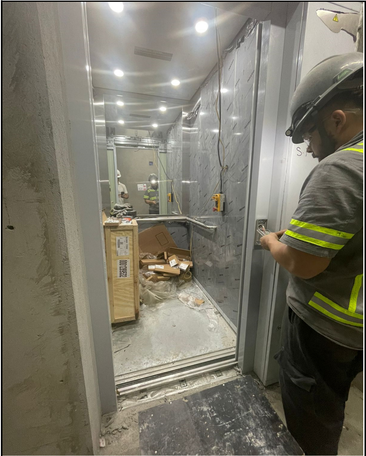
Instalação dos elevadores.
