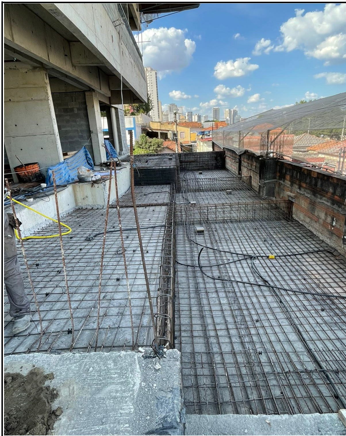
Preparação para concretagem - laje térreo trecho periferia.
