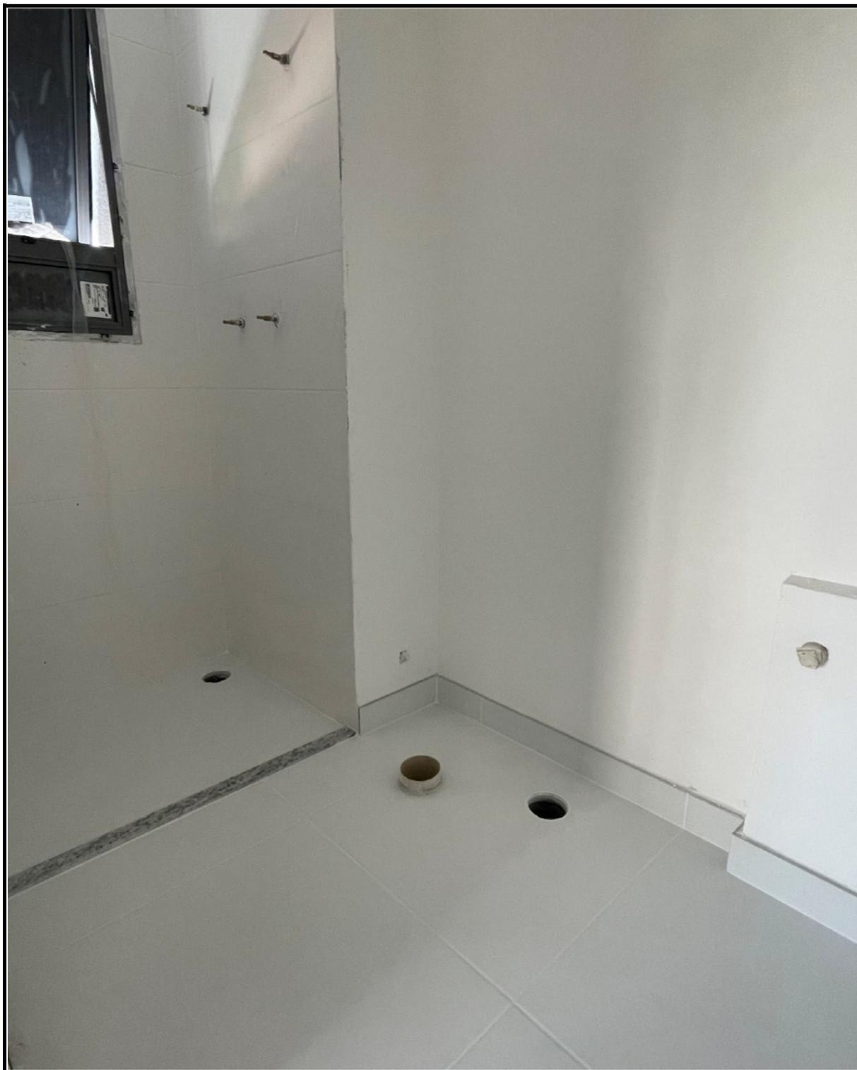
Revestimento cerâmico em paredes e piso - instalação de baguete de granito.
