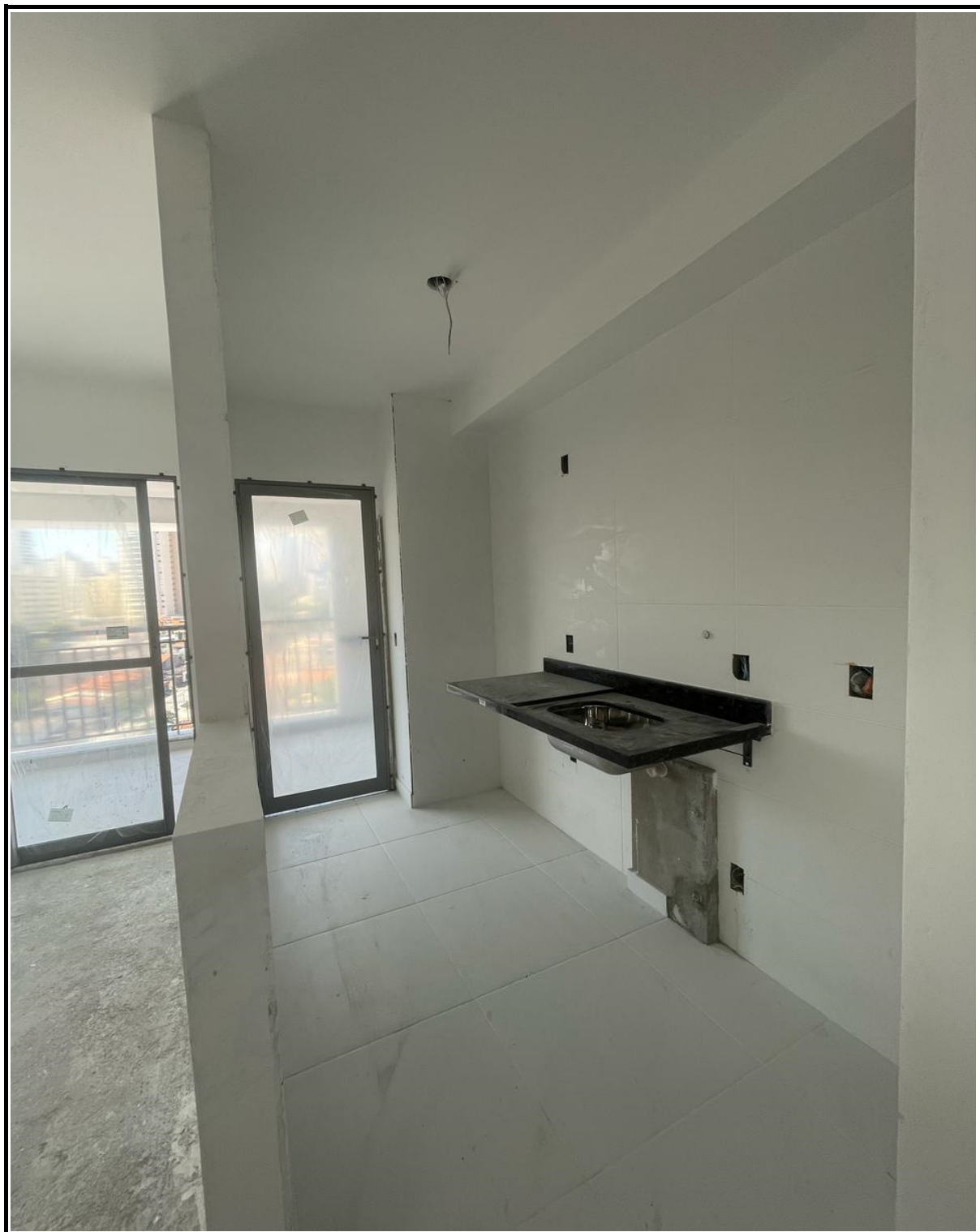
Instalação de bancada de granito nas cozinhas.
