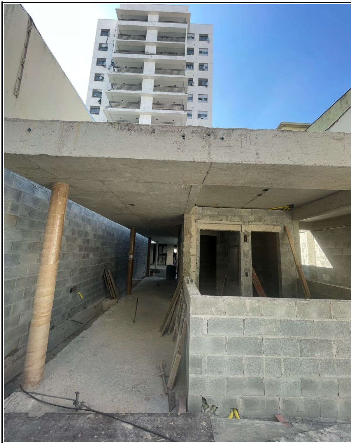
Execução da entrada de pedestres.
