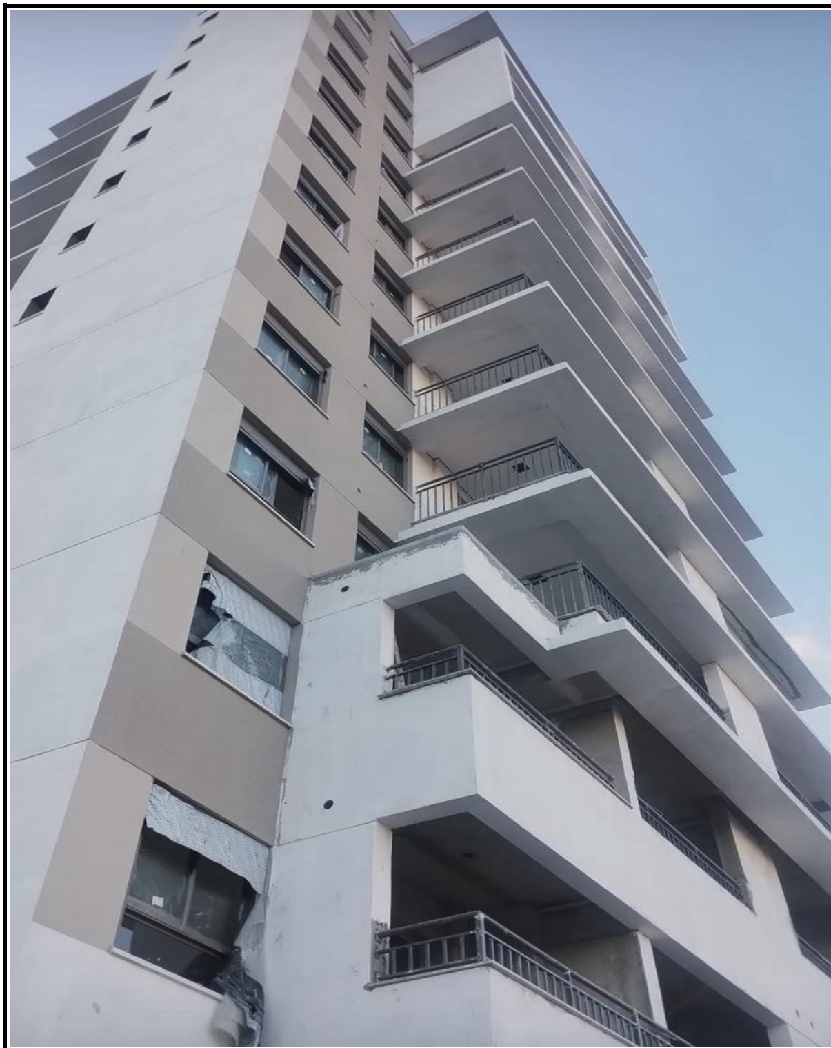
Pintura da fachada.
