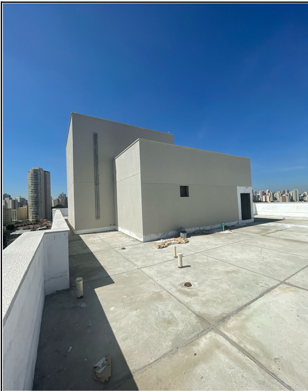
Laje de cobertura da edificação.
