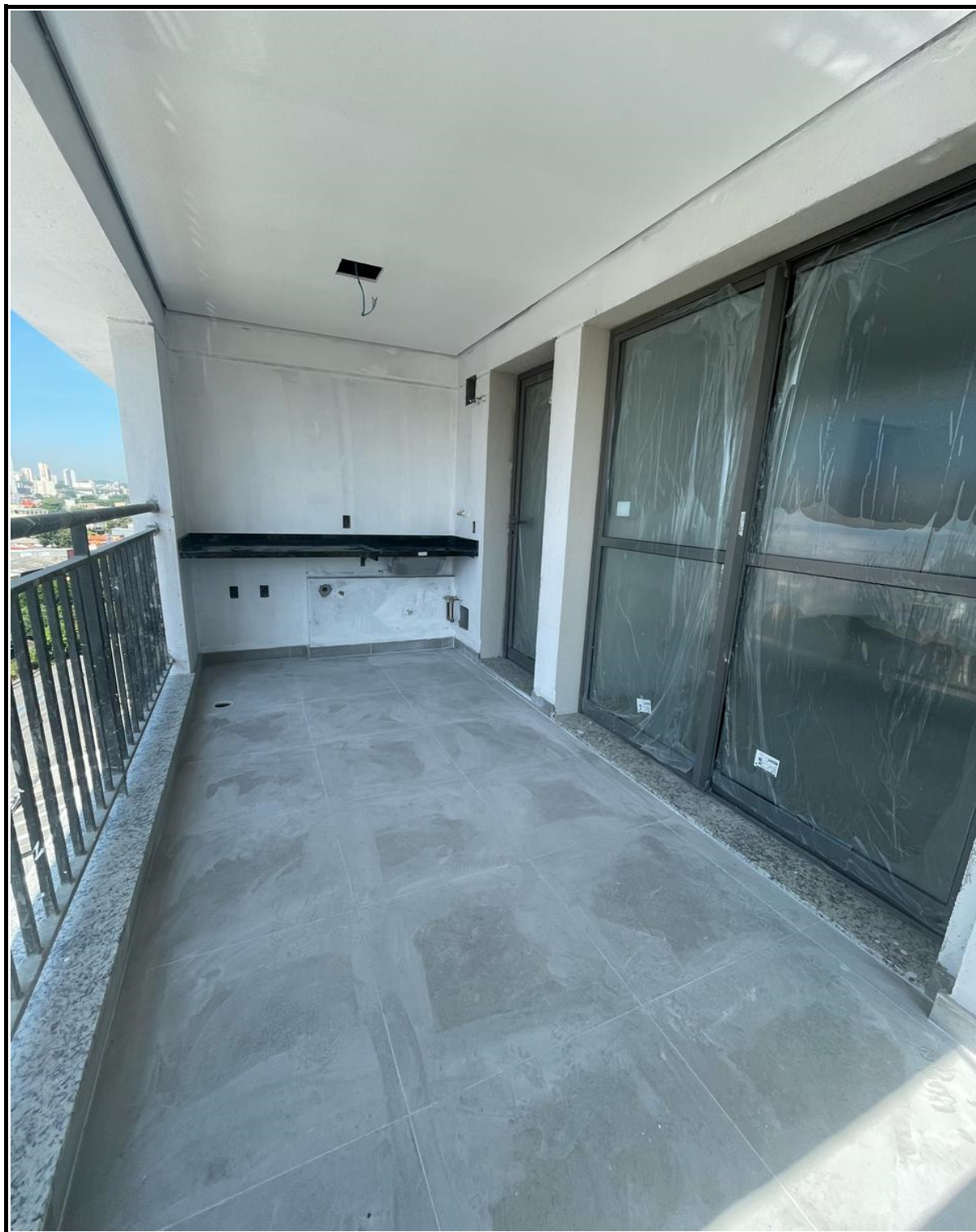
Instalação de piso, caixilhos e bancada de granito nos terraços.
