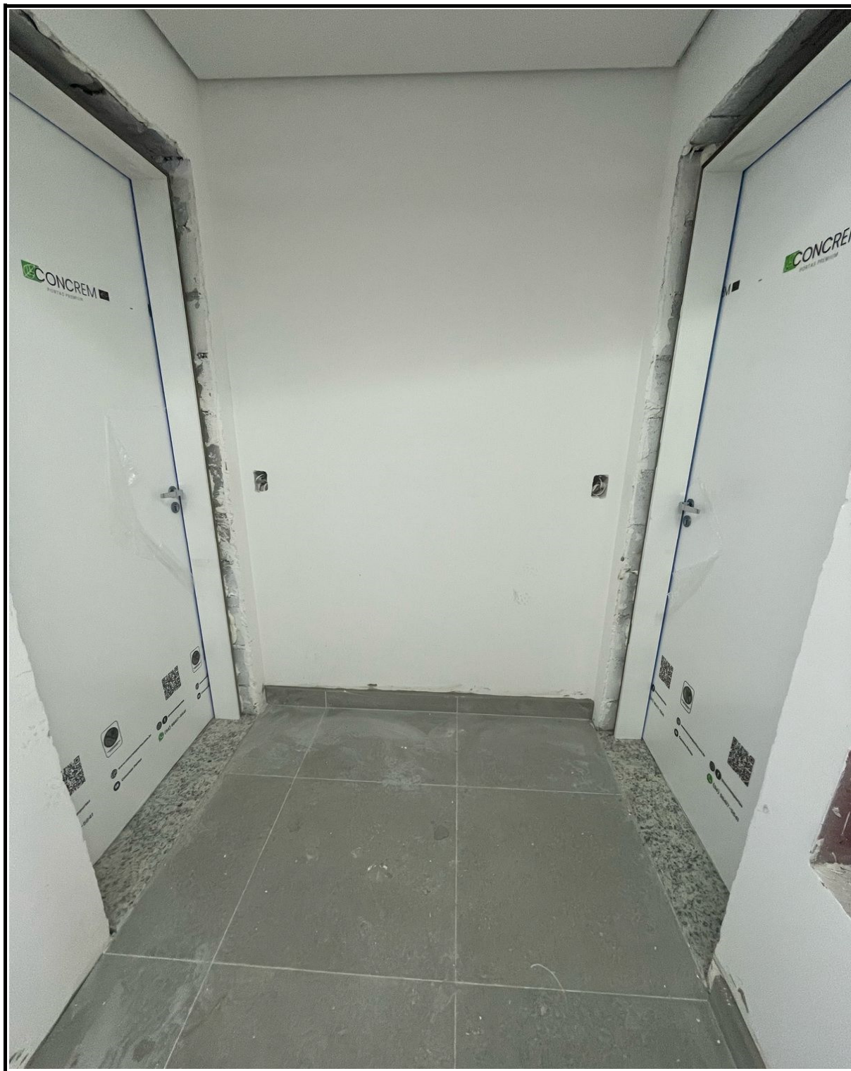
Instalação de portas, pisos e baguetes de granito.
