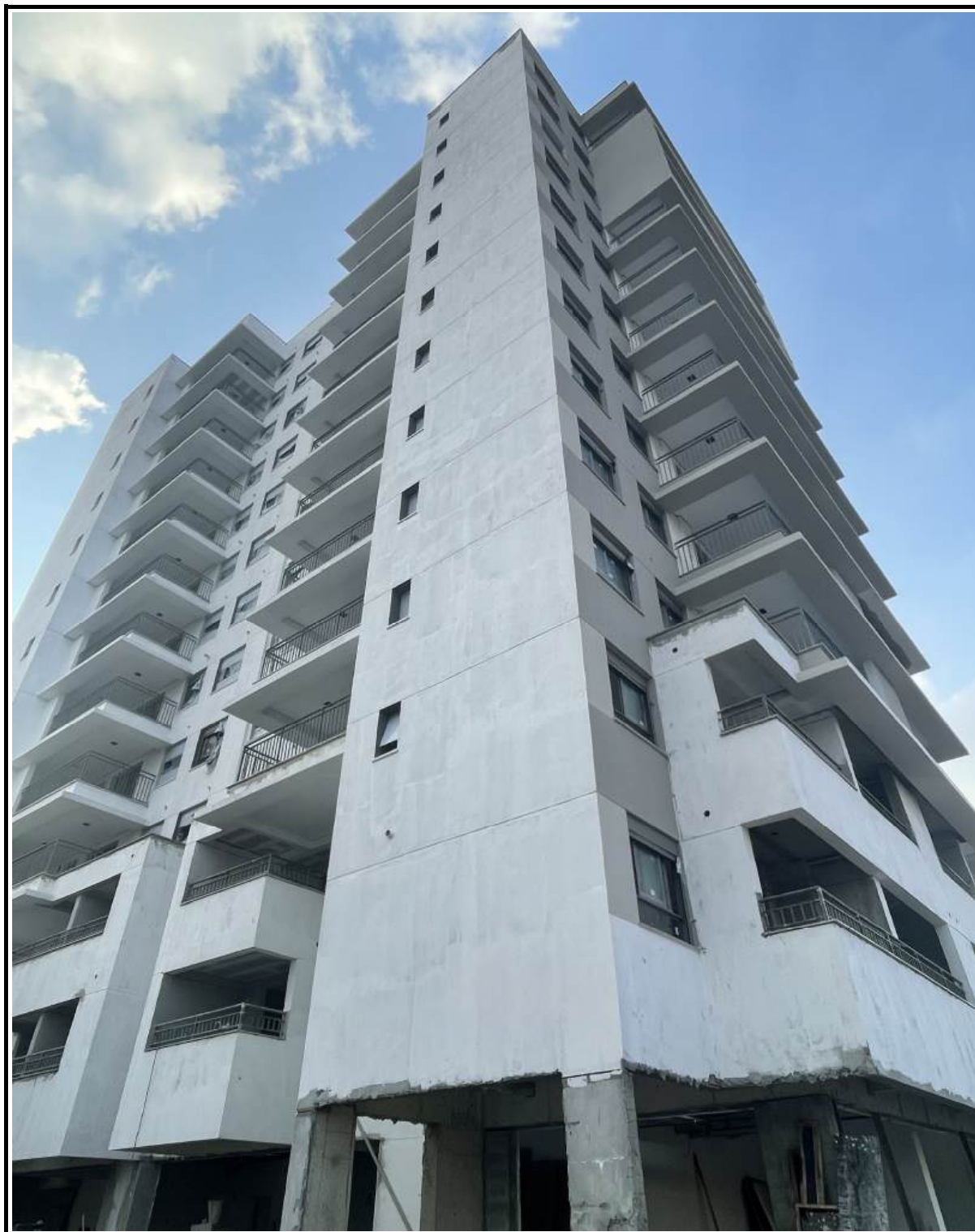
Pintura da fachada.
