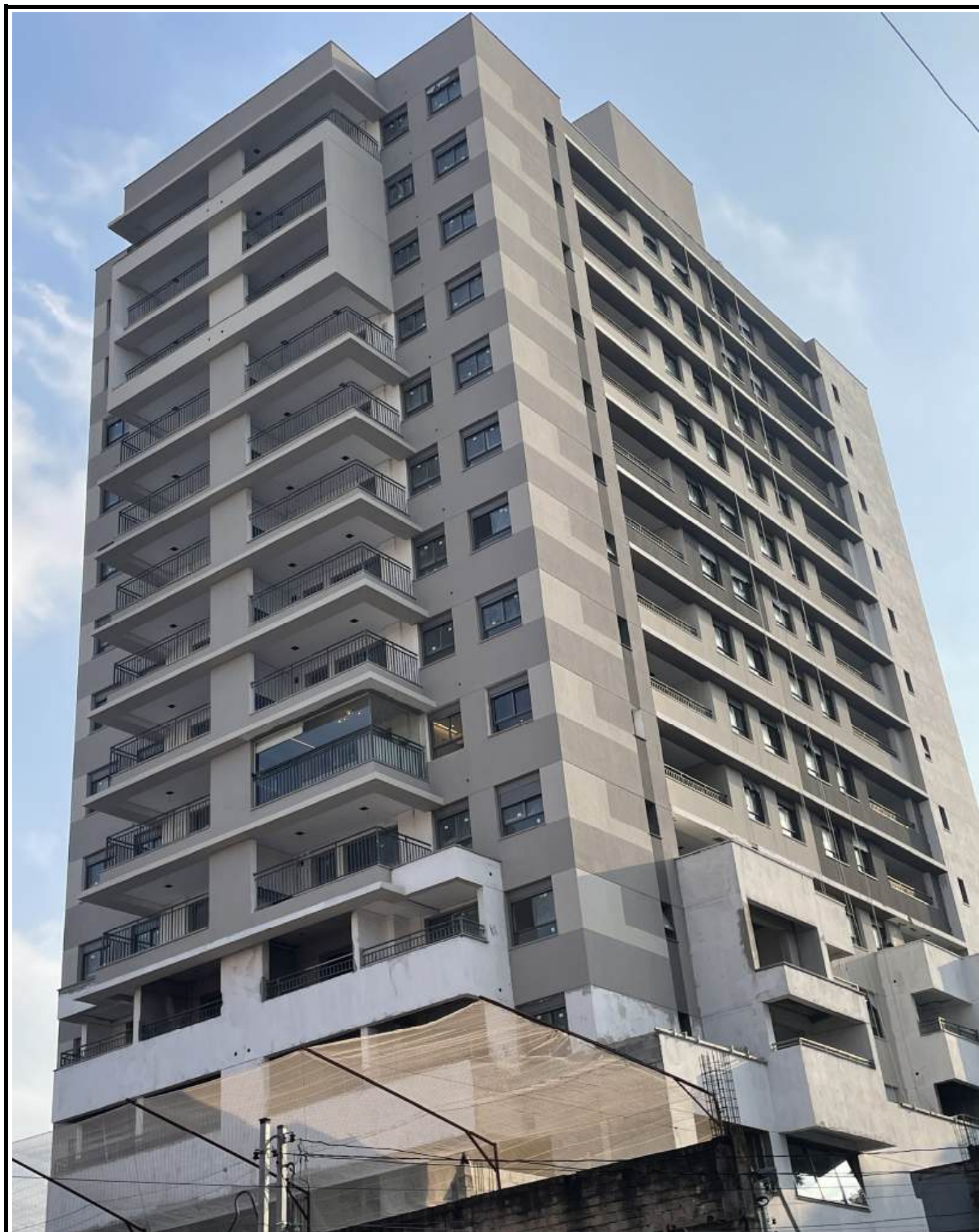
Pintura da fachada.
