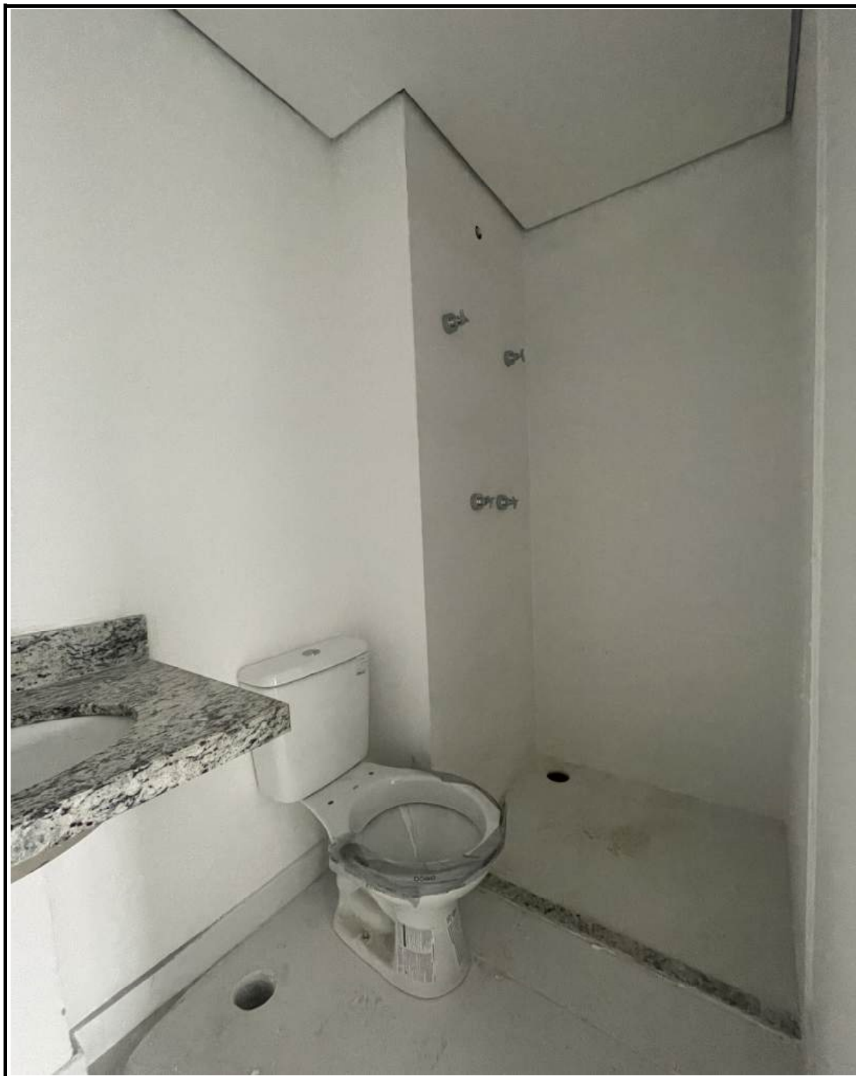
Instalação de granitos e louças nos banhos.
