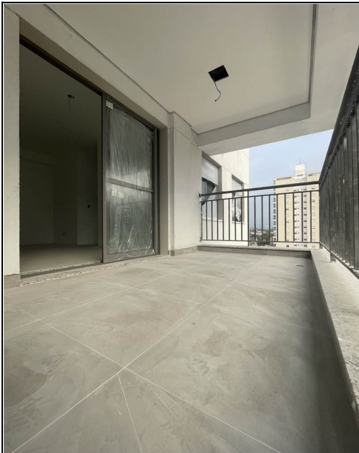
Revestimento cerâmico e caixilharia nos terraços.
