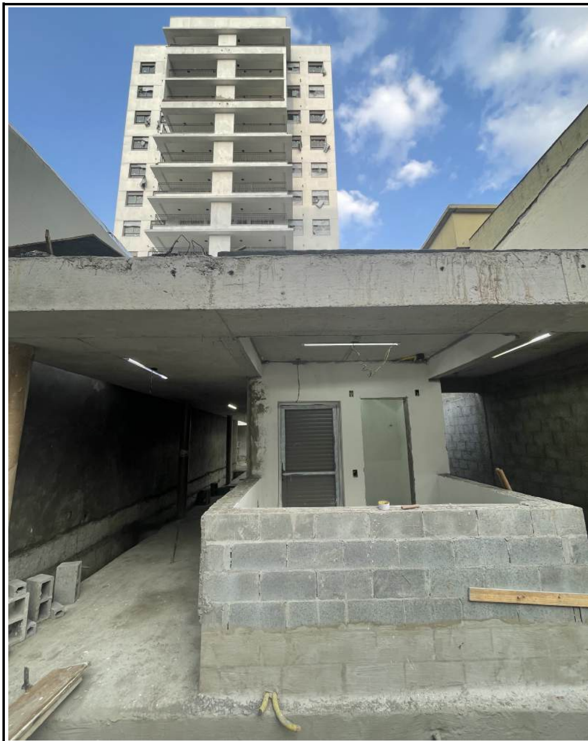
Execução da entrada de pedestres.
