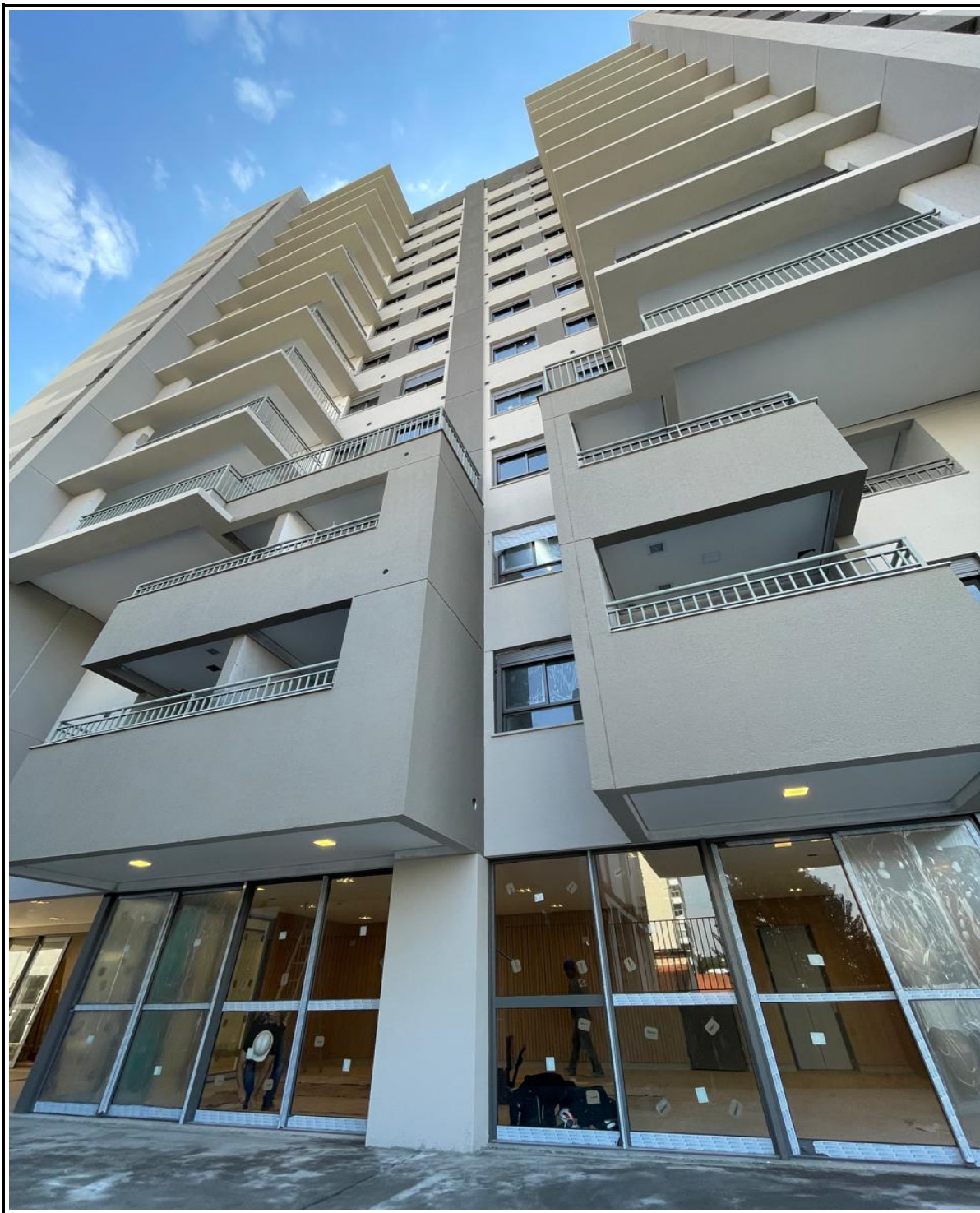
Instalação de caixilhos no andar térreo.
