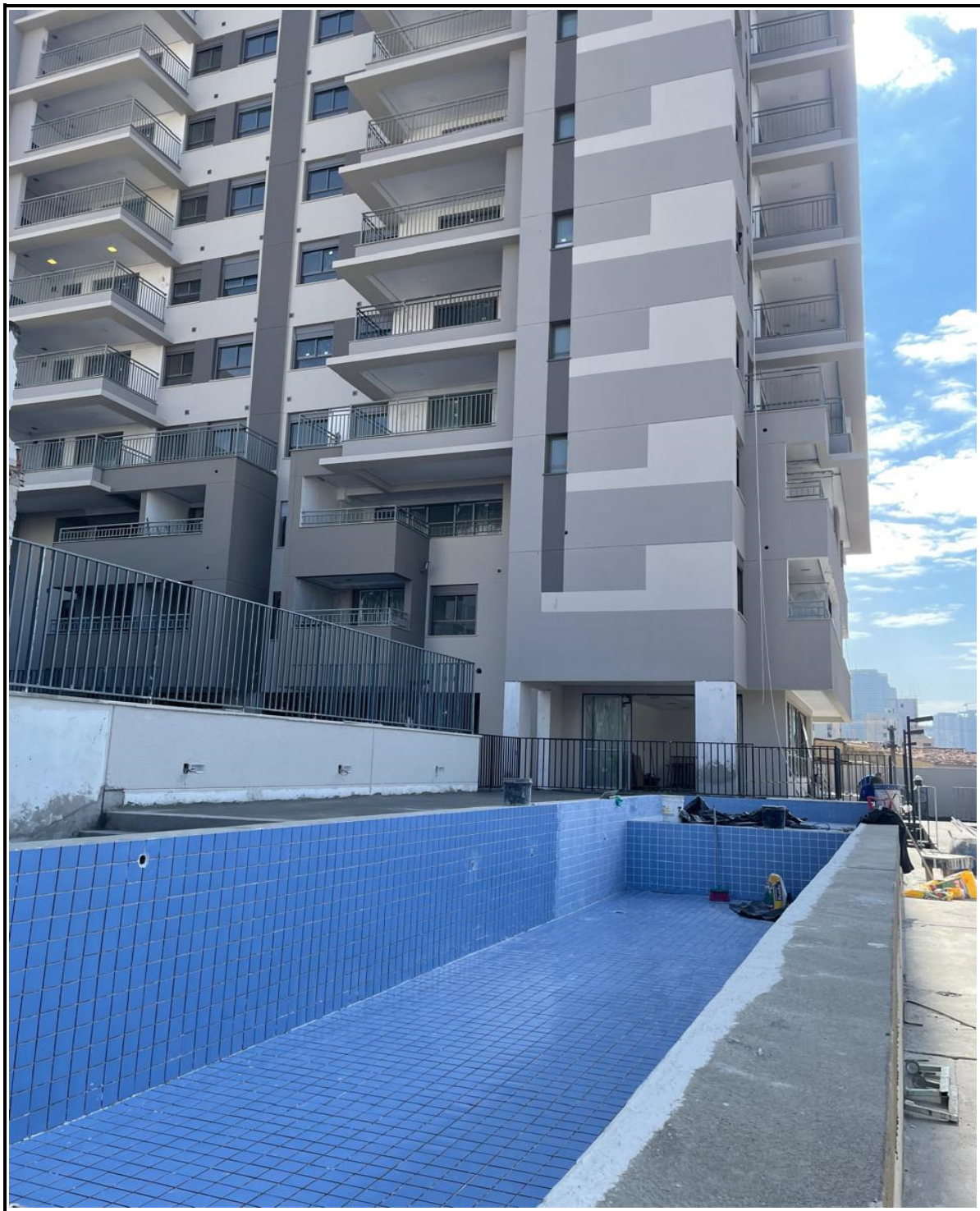
Revestimento cerâmico na piscina.
