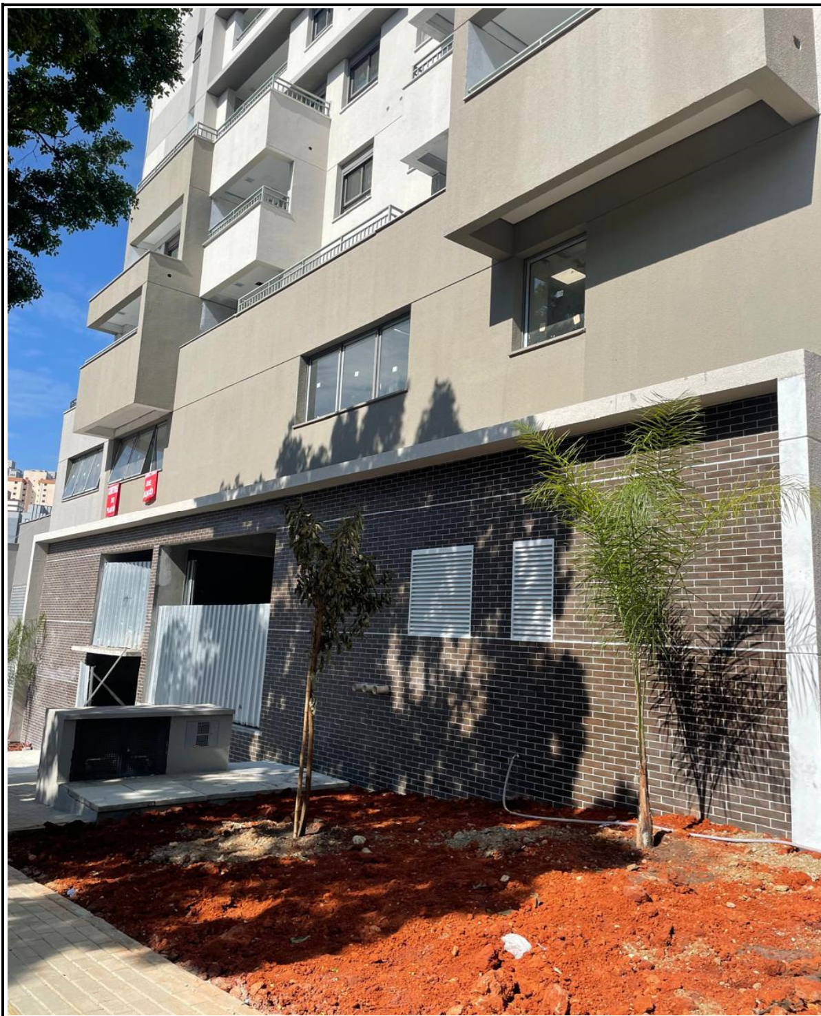
Início da execução do paisagismo.
