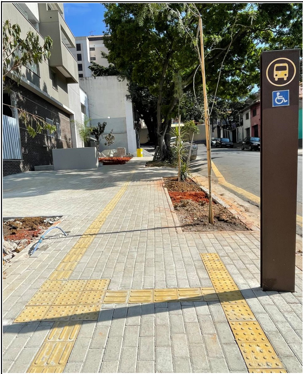
Execução de calçada e paisagismo.
