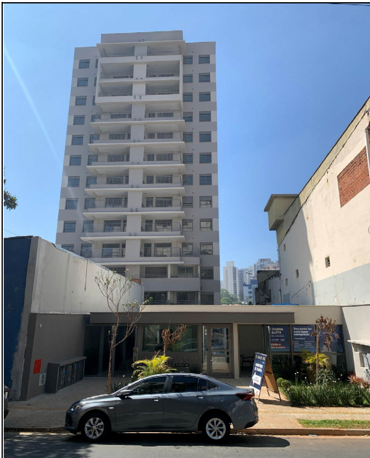
Fachada Rua Santo Irineu
