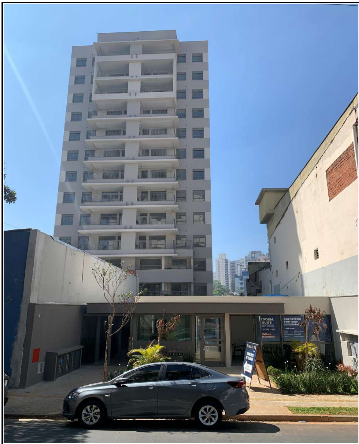
Fachada Rua Santo Irineu
