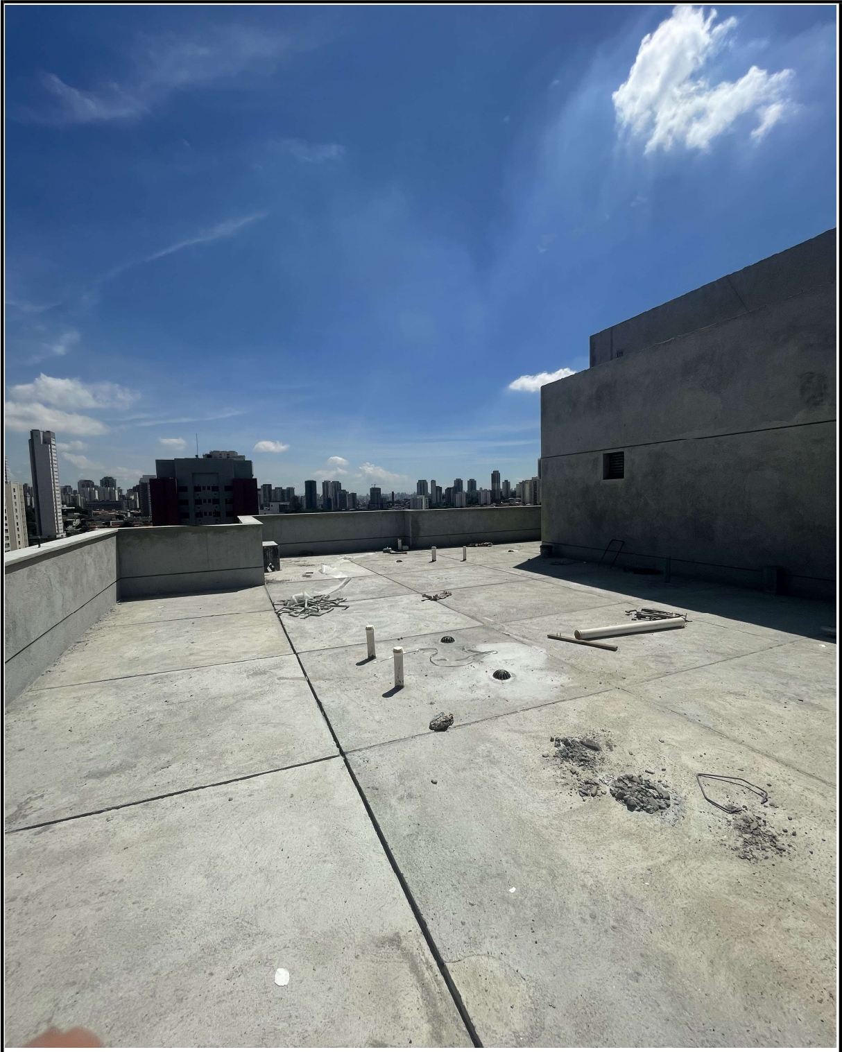
Término dos serviços de impermeabilização na laje de cobertura.
