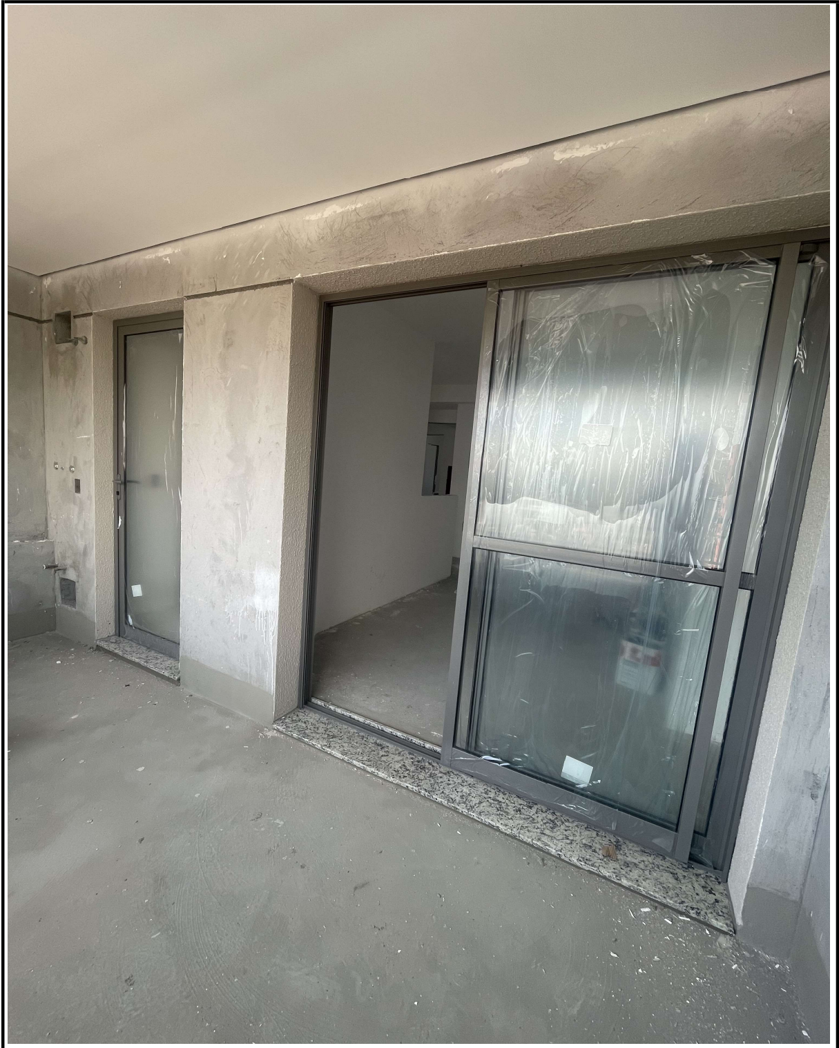
Instalação de caixilharia nos terraços.
