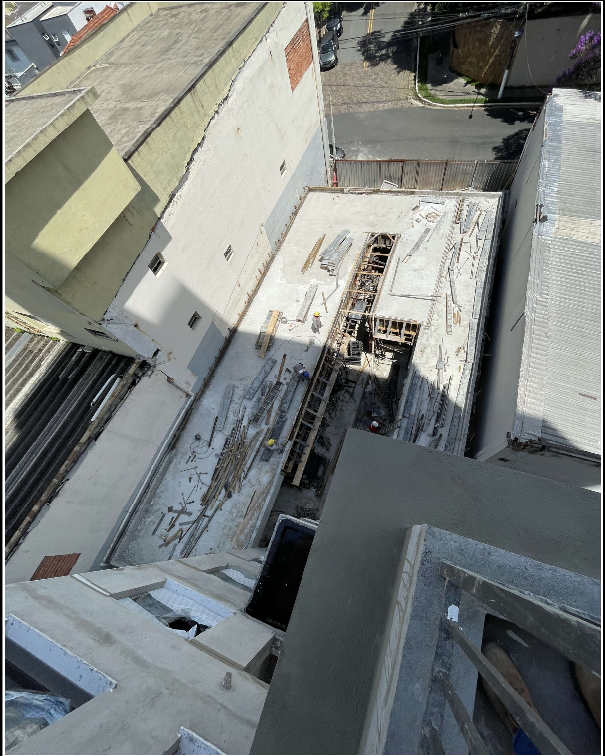
Concretagem da laje de cobertura da entrada do prédio.
