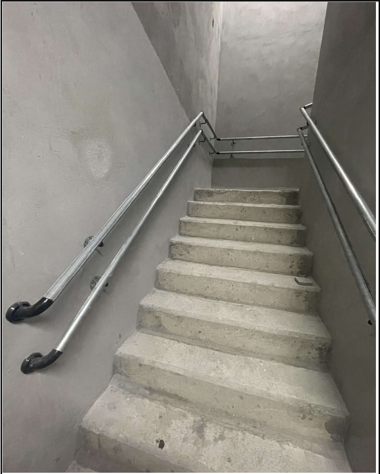
Instalação de corrimão e regularização da escadaria.
