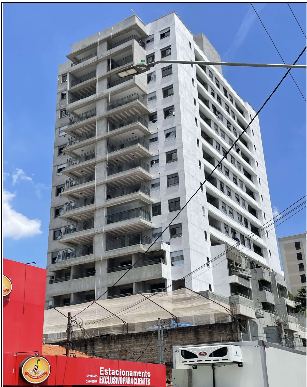
Vista fachada - Av. Ricardo Jafet.
