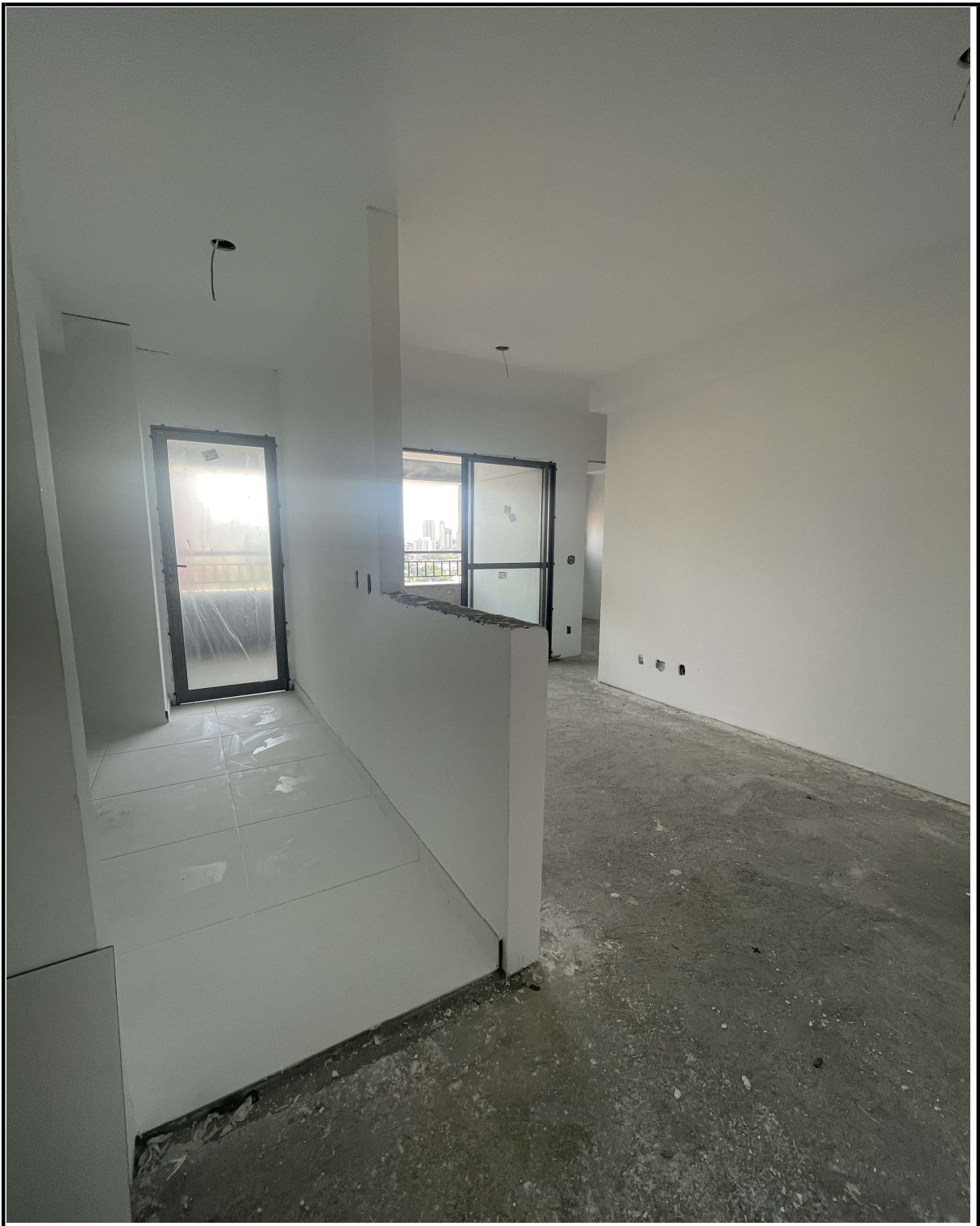
Pintura, revestimento cerâmico e caixilharia nos apartamentos.
